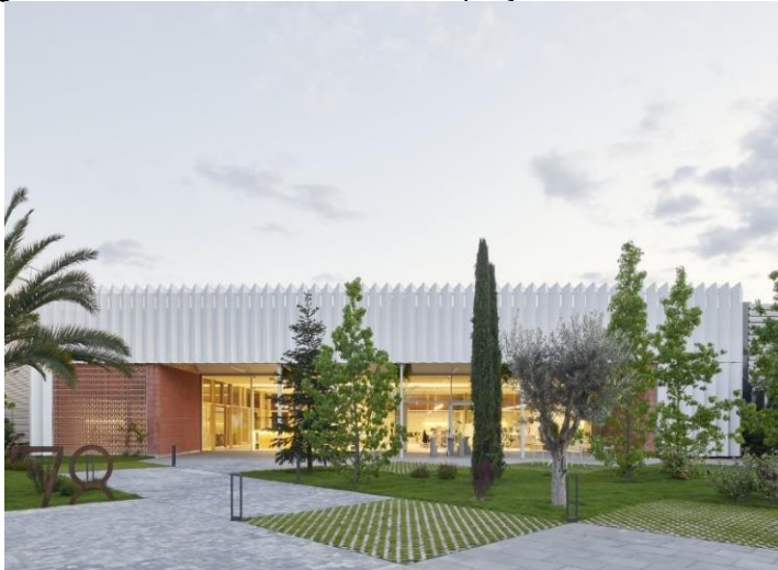
Figura 16 – Fachada frontal O78! Adaptação de edifício industrial
