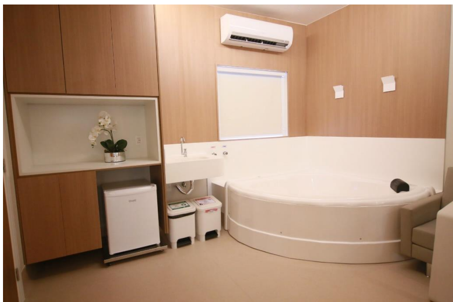
Figura 07 – Detalhes da banheira na sala de parto
