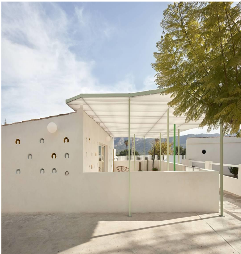
Figura 22 - Fachada Lateral do Refúgio Las Cuadras
