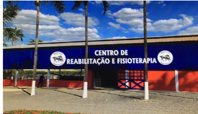
Figura 43- Fachada principal do Central Equus
