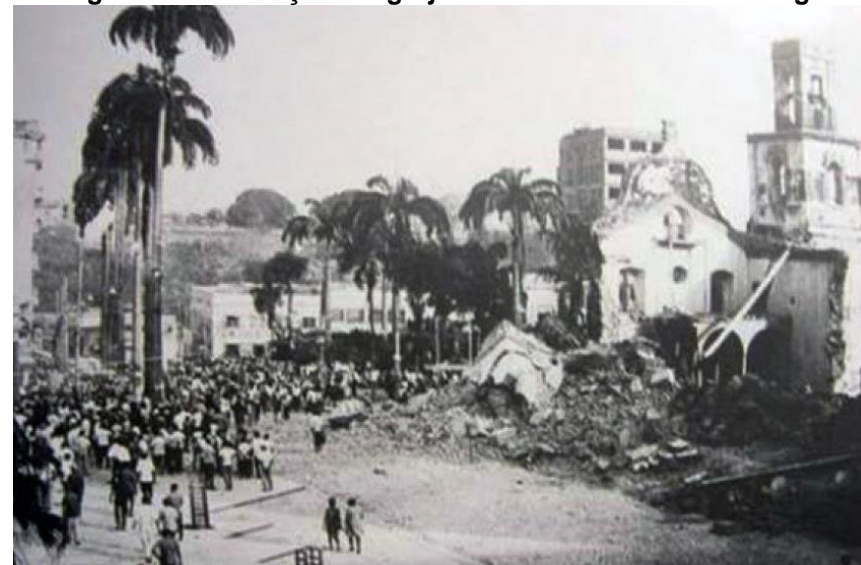
Figura 16: Demolição da Igreja Bom Jesus de Cuiabá Antiga
