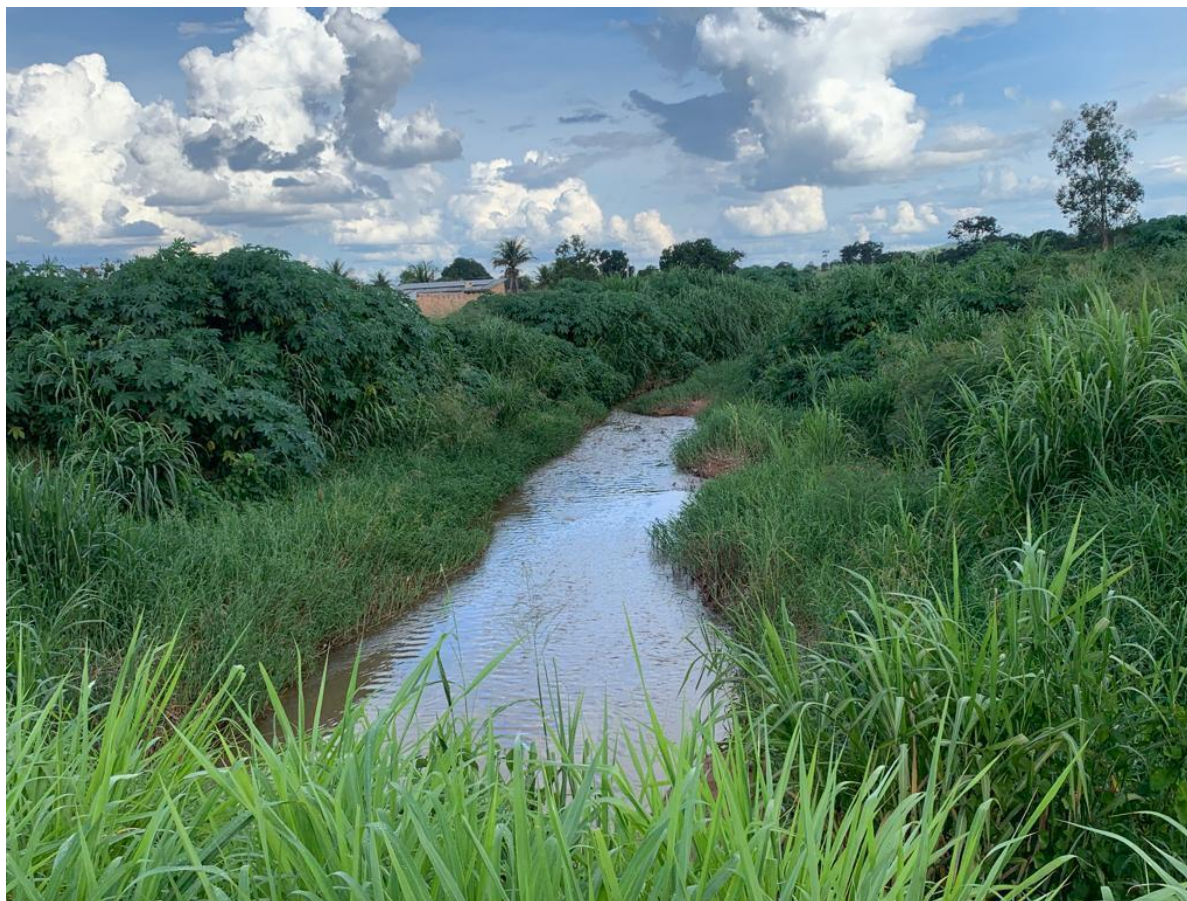
Figura 28 - Parte Não Canalizada do Córrego da Lavadeira (b)
