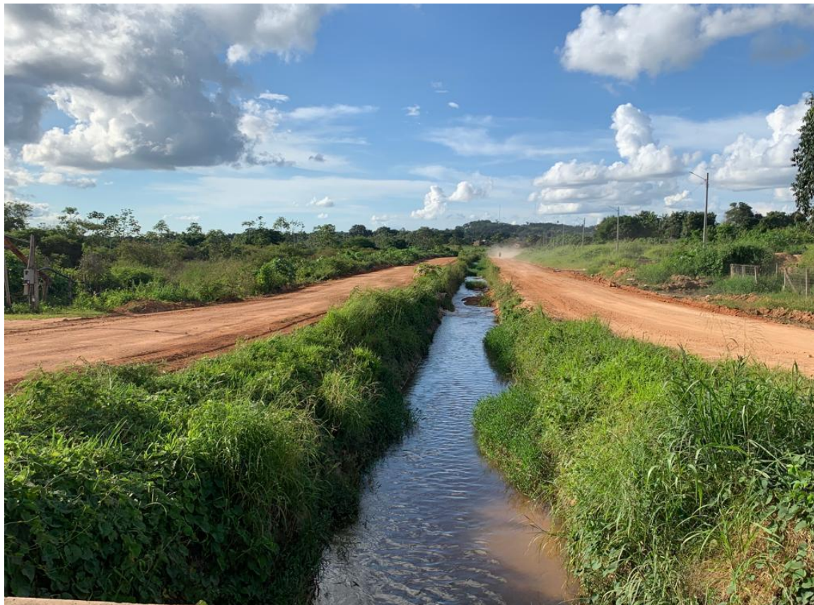
Figura 27 - Parte Canalizada do Córrego da Lavadeira (a)
