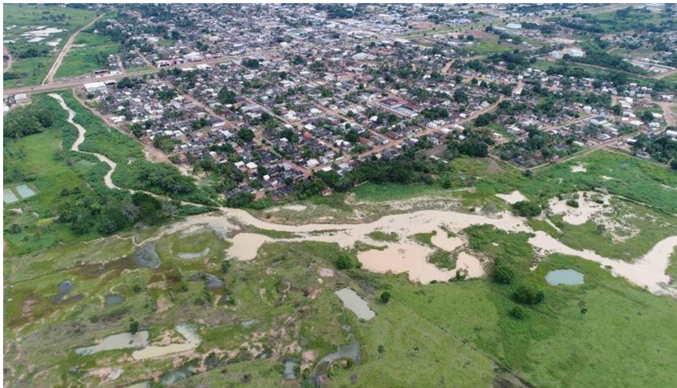
Figura 31 - Imagem Córrego da Lavadeira - Parte Não Canalizada
