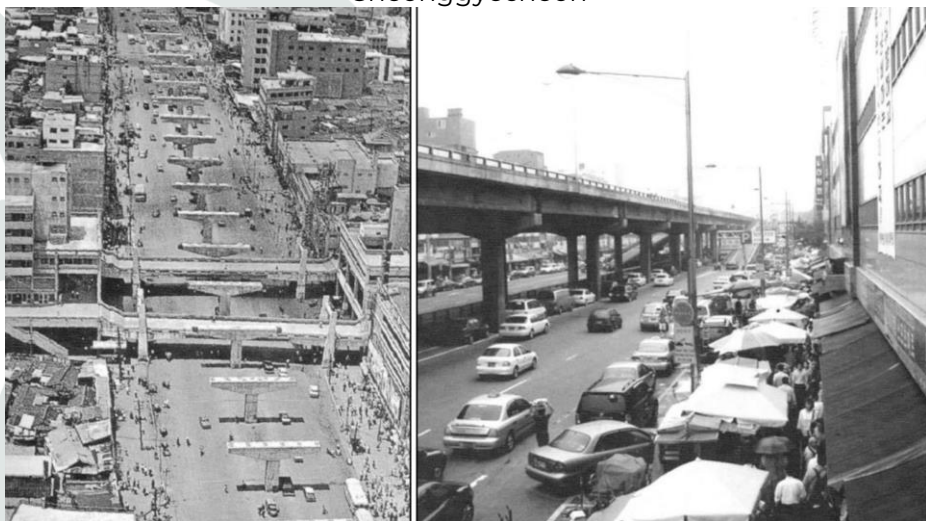
Figura 15 - A via elevada sobre o antigo leito do Córrego Cheonggyecheon
