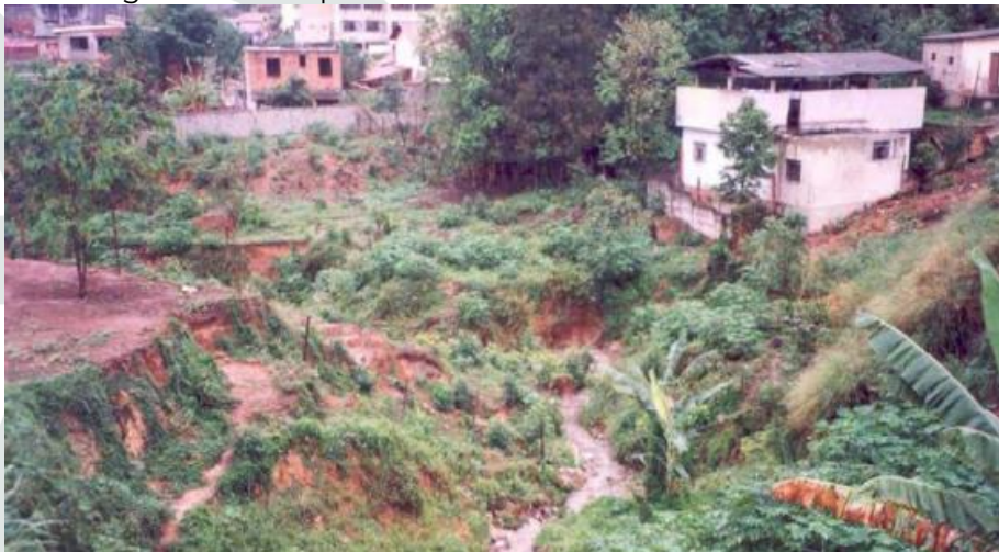
Figura 23 - Parque 1º de Maio - Antes do início das obras.
