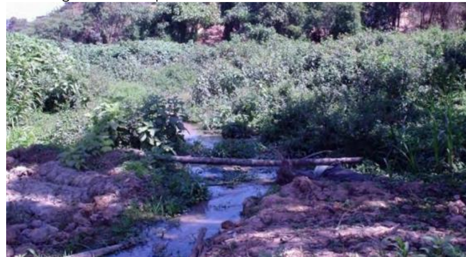
Figura 24 - Parque 1º de Maio - Antes do início das obras
