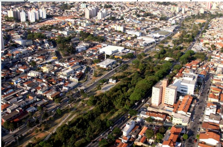
Figura 66 - Vista aérea do Parque Linear Tiquara
