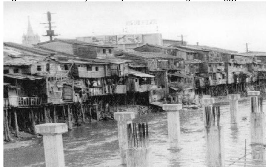
Figura 14 - A construção das lajes sobre o Córrego Cheonggyecheon.
