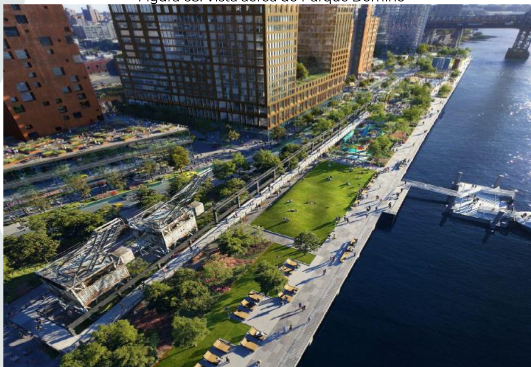
Figura 68: Vista aérea do Parque Domino
