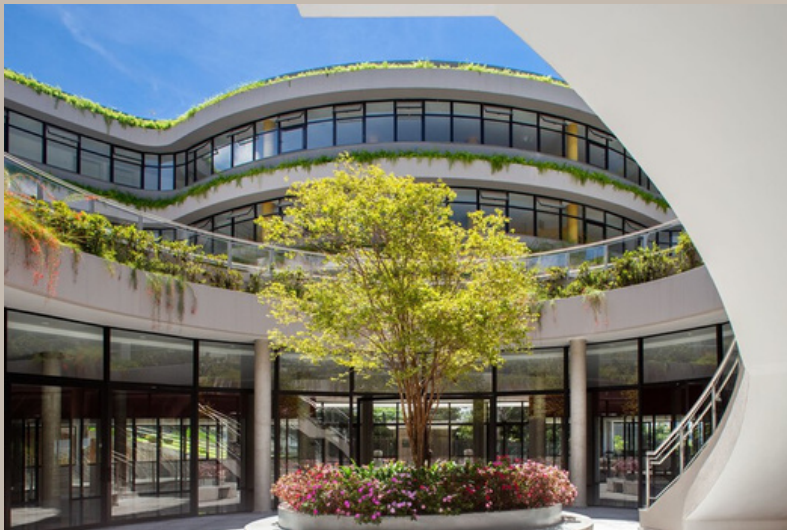
Figura 29: Pátio central - Hakka Residencial
