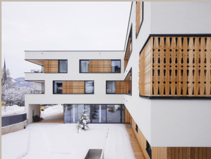
Figura 11: Elementos da fachada da Casa de repouso Wilder Kaiser
