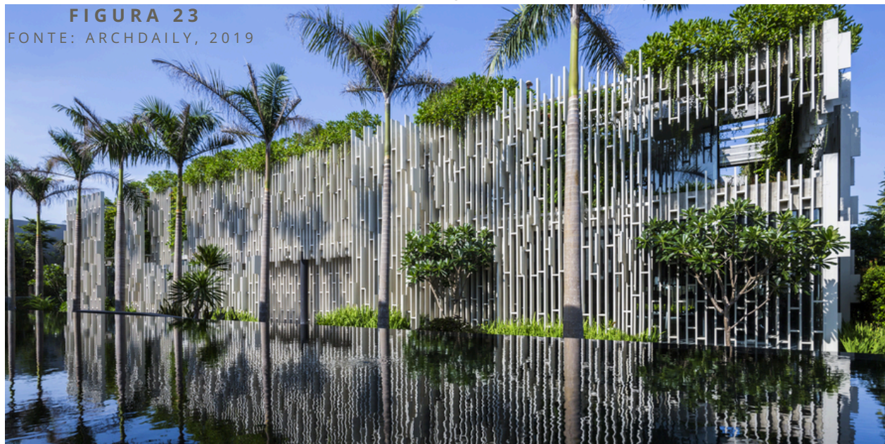
Visualização da fachada posterior do edifício.
