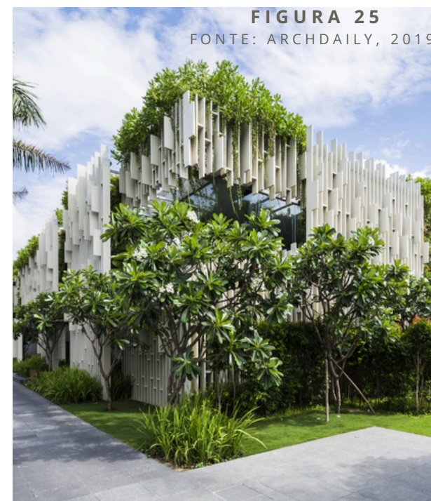
Visualização da fachada lateral do edifício.
