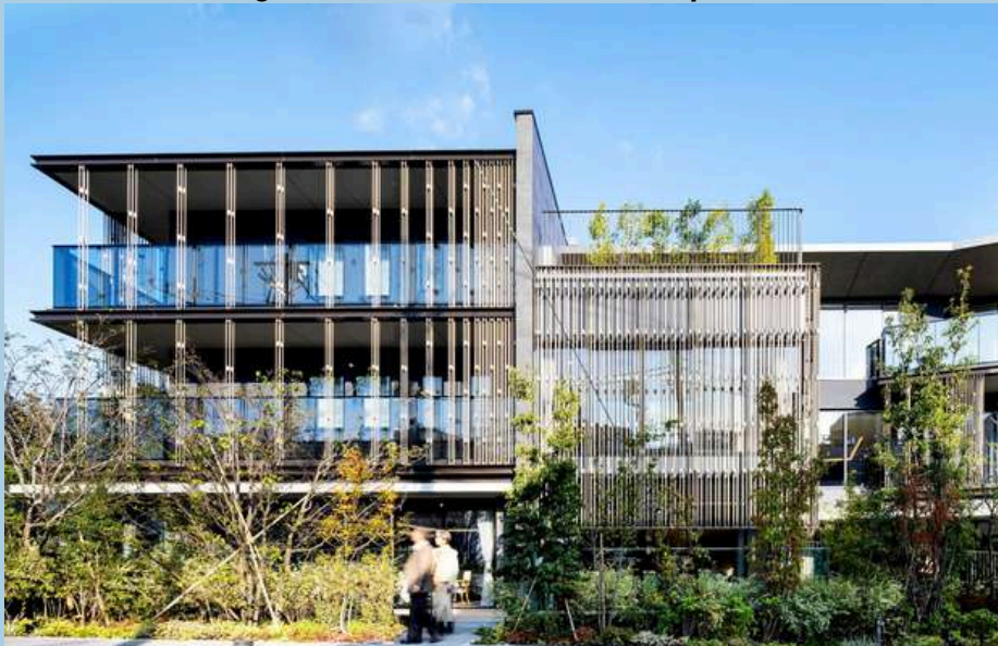
Figuras 25: Fachada Casa de Repouso
