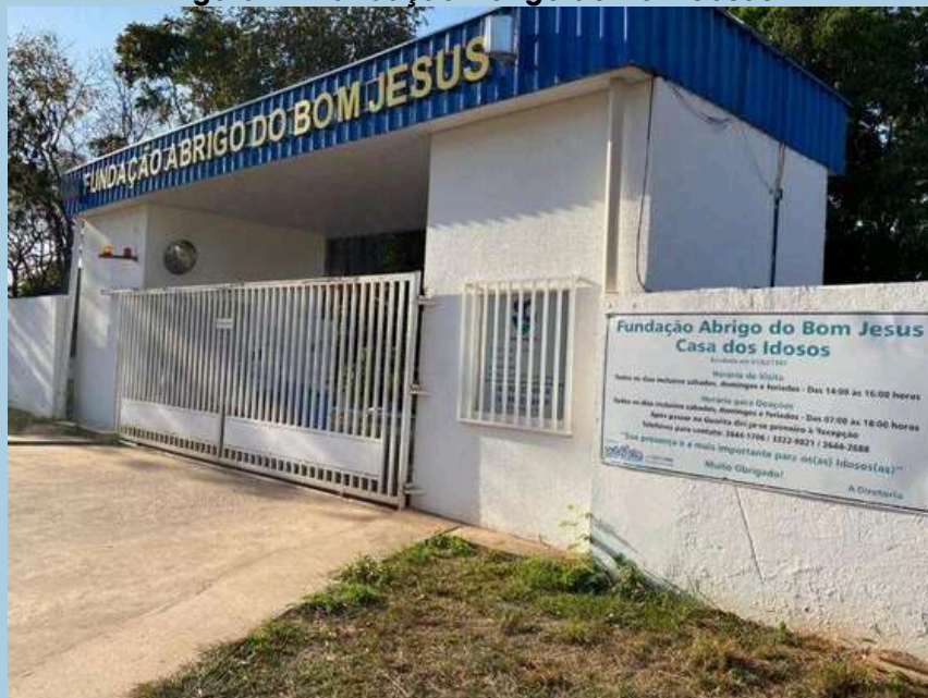
Figura 19: Fundação Abrigo do Bom Jesus
