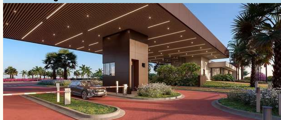
Figura 29: Portaria Condomínio Cidade Jardim
