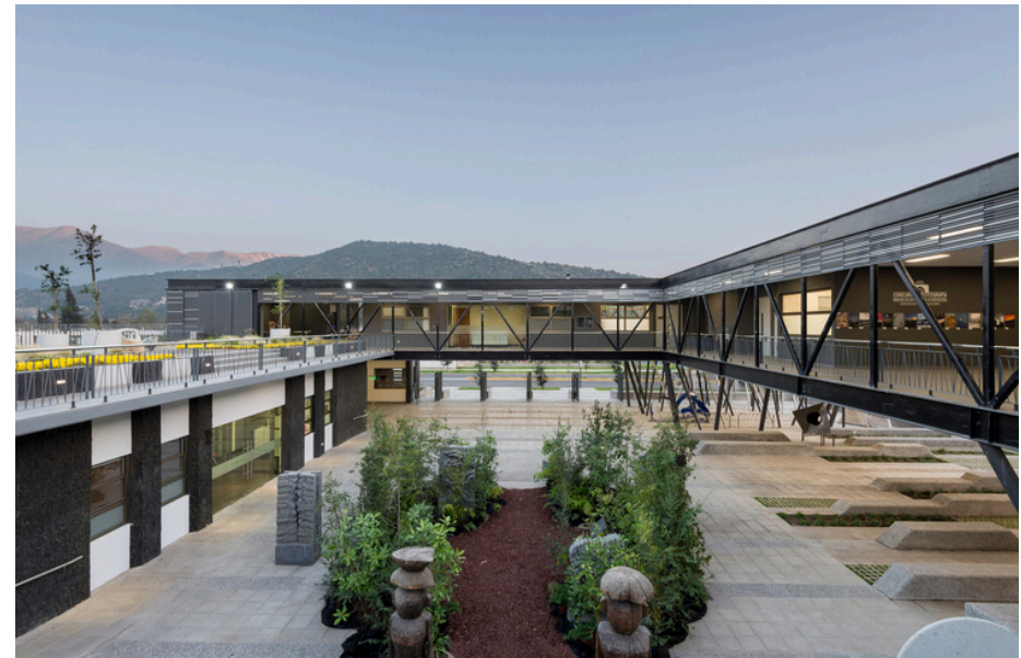
Figura 36: Pátio Central Centro Cultural El Tranque
