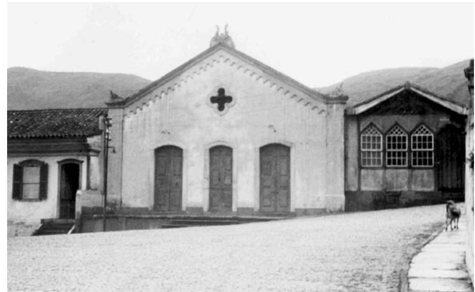
Figura 14: Fachada Casa da Ópera
