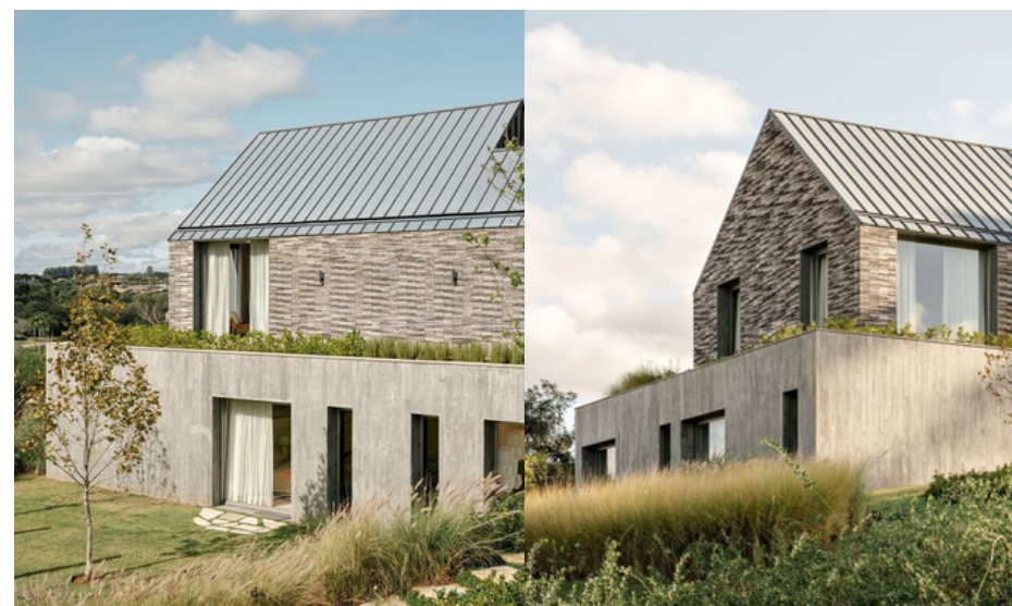
Figuras 28 e 29 - Vistas externas da edificação
