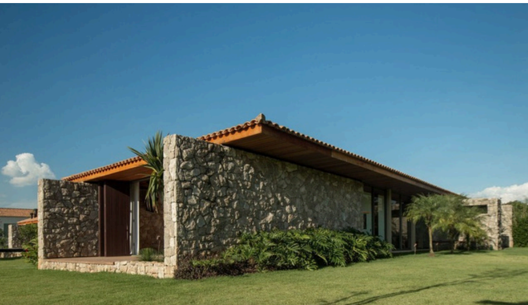
Figura 36 - Revestimento de pedra natural
