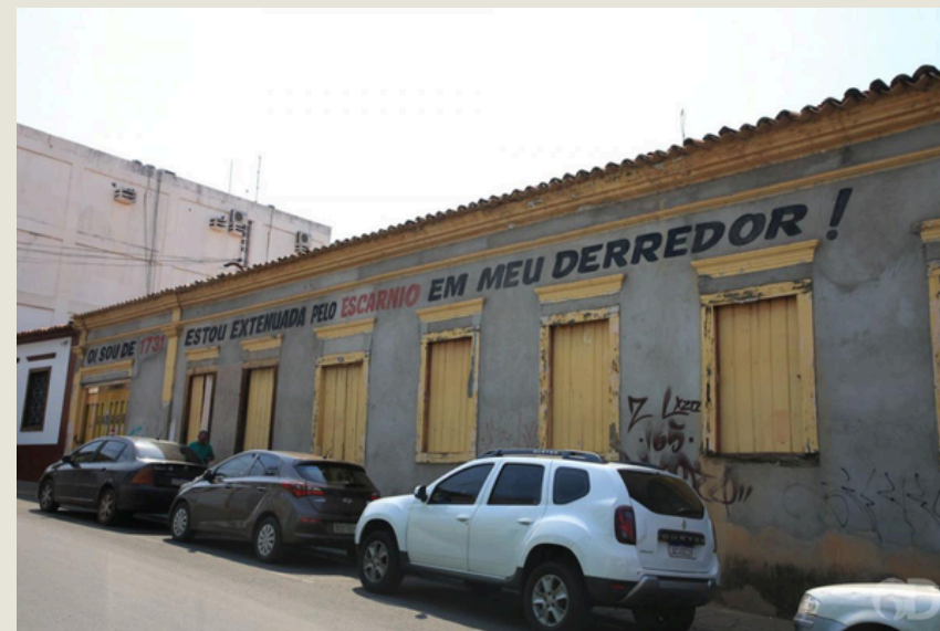
Figura 16 — Fachada Atual Casa 300
