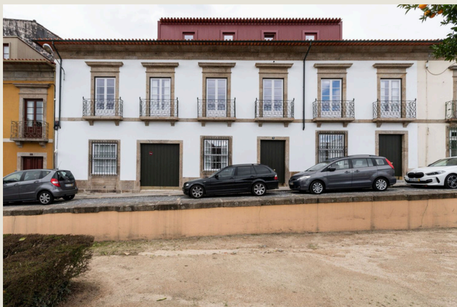
Figura 23 — Fachada , Casa no Campo Novo
