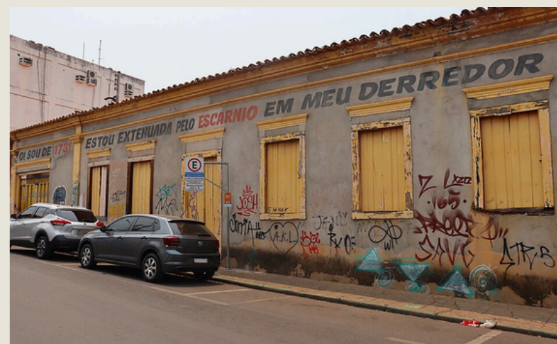
Figura 17 — Fachada Atual Casa 300
