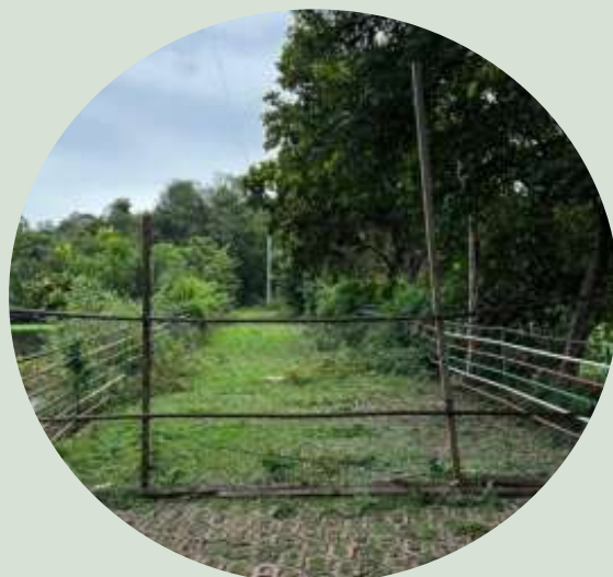
Figura 17: Acesso interditado do Pier
