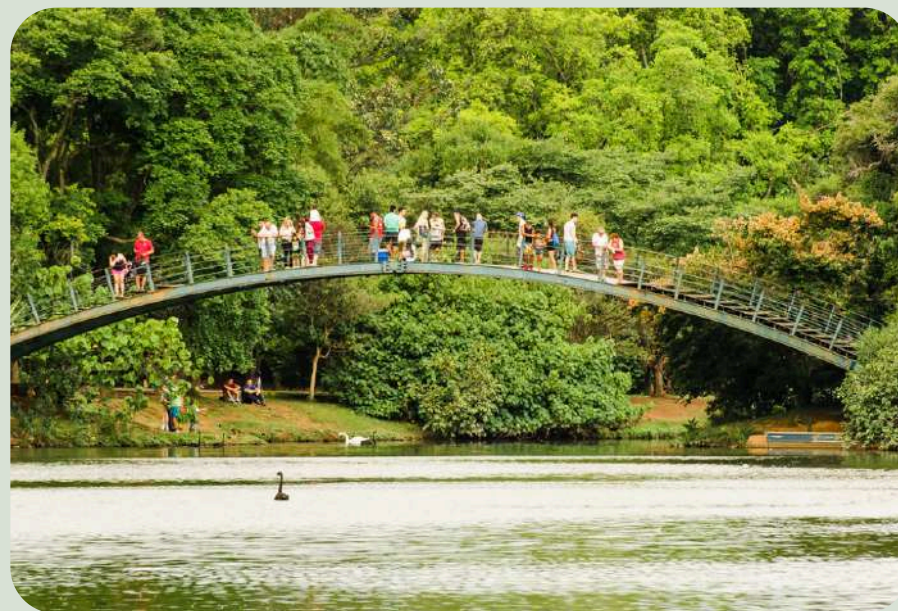
Figura 49: Vista 2 da ponte metálica
