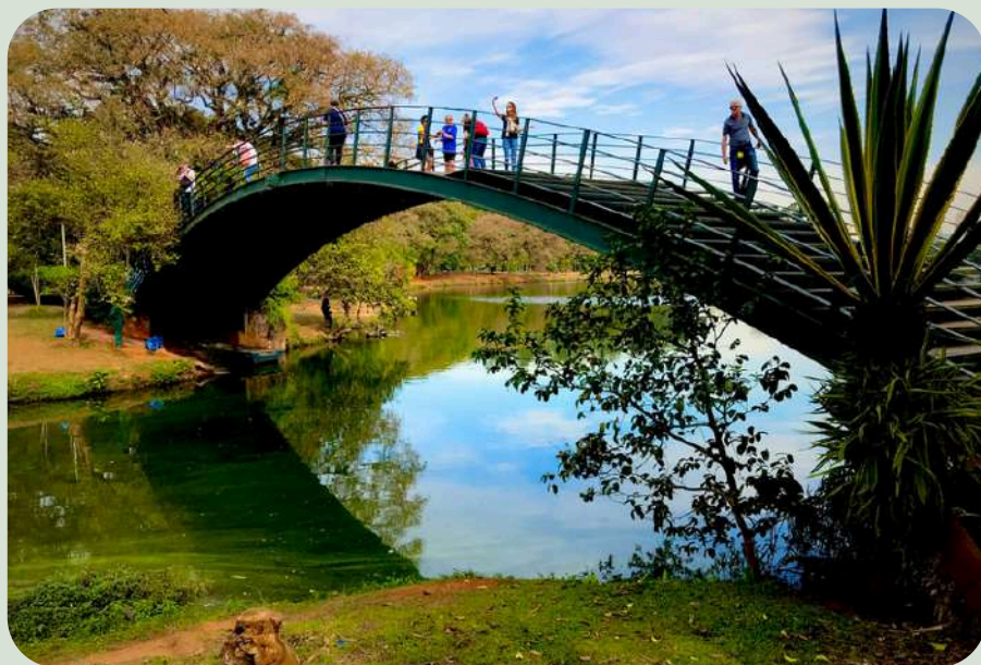
Figura 48: Vista 1 da ponte metálica
