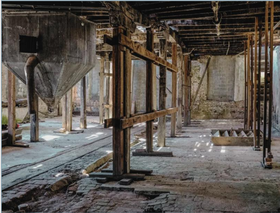
Figura 45: Interior da Usina Itaicy.
