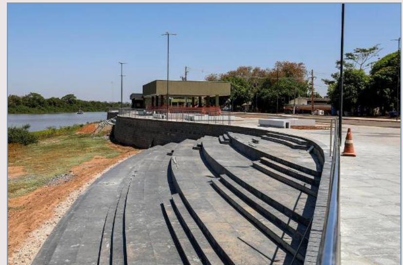
Figura 30: Obra da Orla de Santo Antônio do Leverger.
