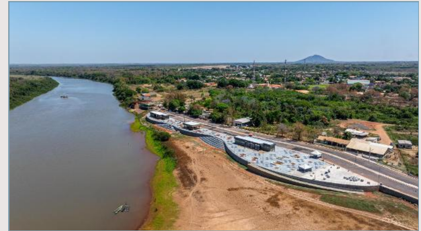
Figura 29: Vista aérea da obra da Orla de Santo Antônio do Leverger.
