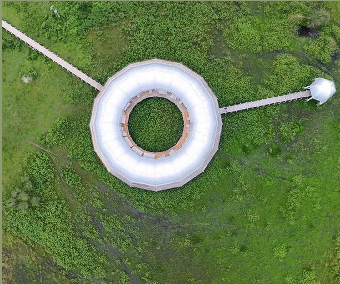
Figura 09: Vista aérea do Memorial Marechal Rondon em Mimoso, Santo Antônio do Leverger - MT. Fonte: https://g1.globo.com/mt/mato-grosso/noticia/2022/04/21/apos-abandono-memorial-de-marechal-rondon-em-mt-deve-ser-reformado-ainda-neste-ano-diz-secretaria.ghtml
