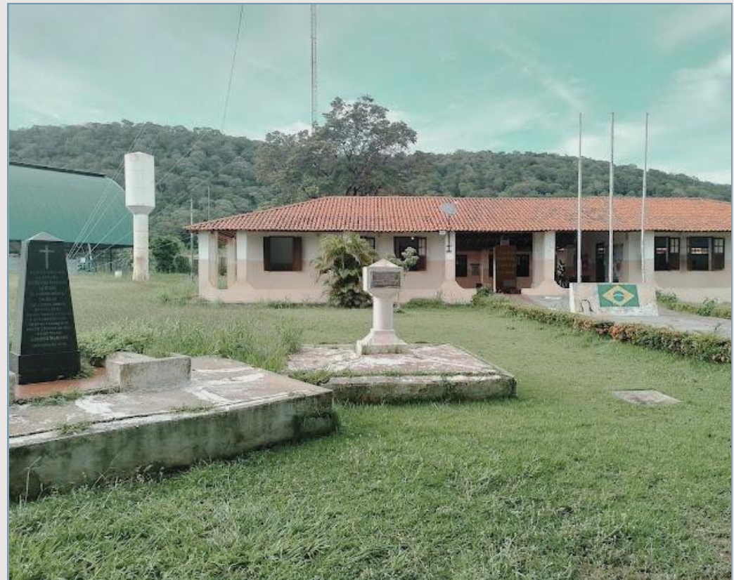
Figura 37: Escola Estadual Santa Claudina no distrito de Mimoso- Santo Antônio de Leverger Fonte: SINTEP MT (2023)
