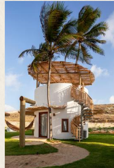
FIGURA 17: VISTA EXTERNA BANGALÔ
