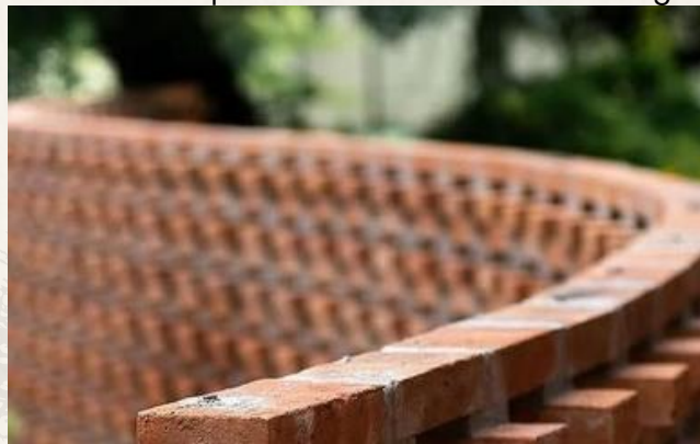
FIGURA 36: parede curva com cobogó
