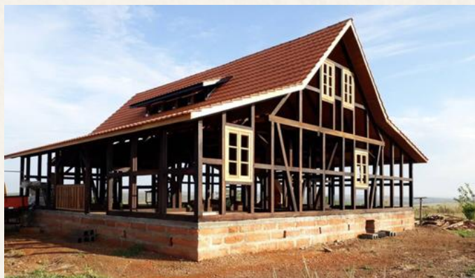
FIGURA 37: telhado enxaimel com telha chata
