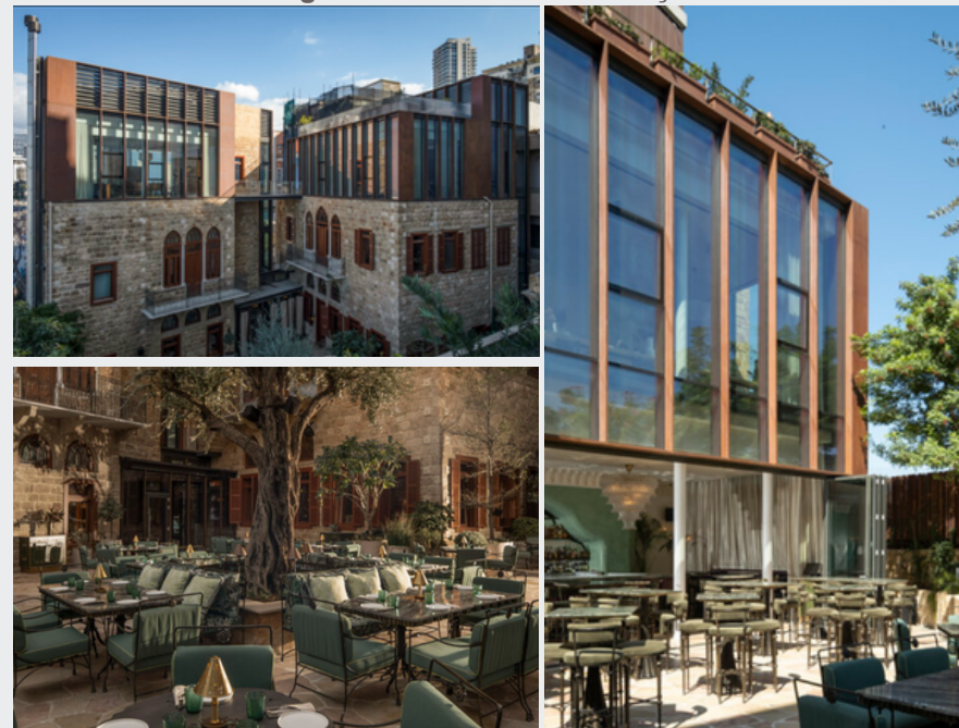
Figura 20 - Vistas da edificação.
