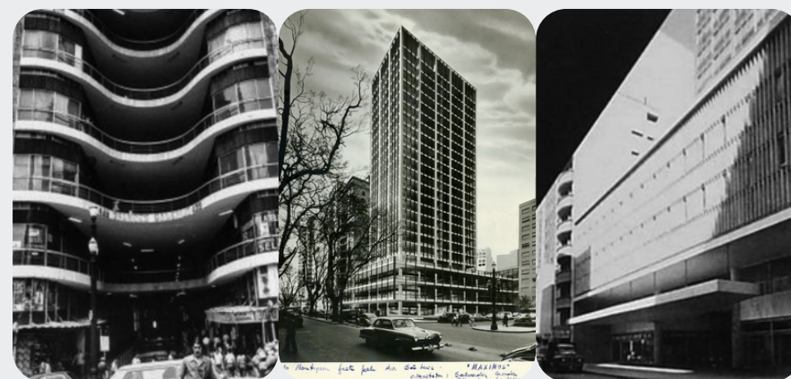
Figura 5 - Edifícios-galeria São Paulo
