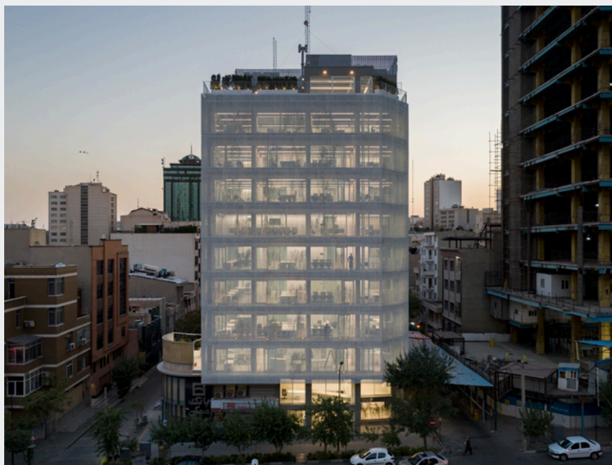
Figura 12 - Vista da fachada do edifício.
