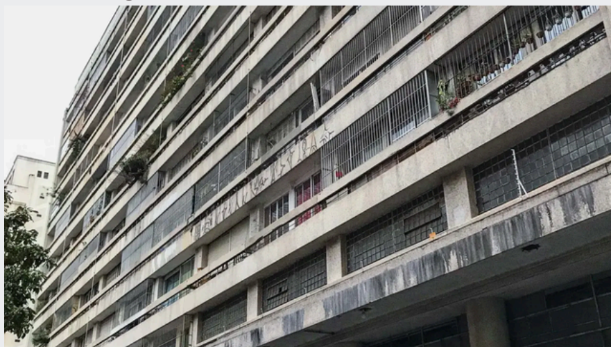
Figura 23 - Fachada atualmente do Edifício Mara.
