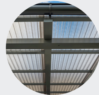
Estrutura metálica marquise
