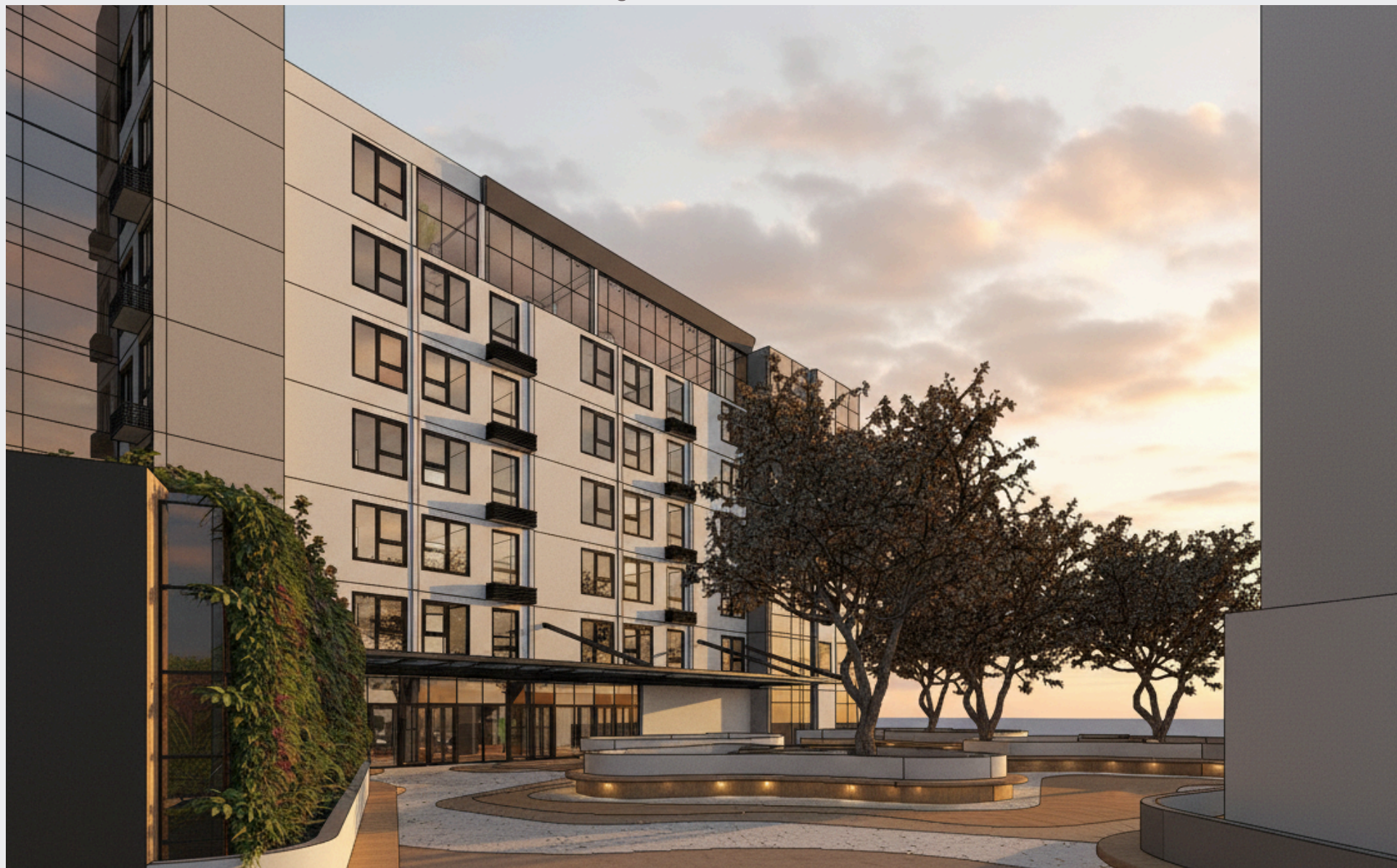
Figura 75 - Vista Pedestre Pátio Central
