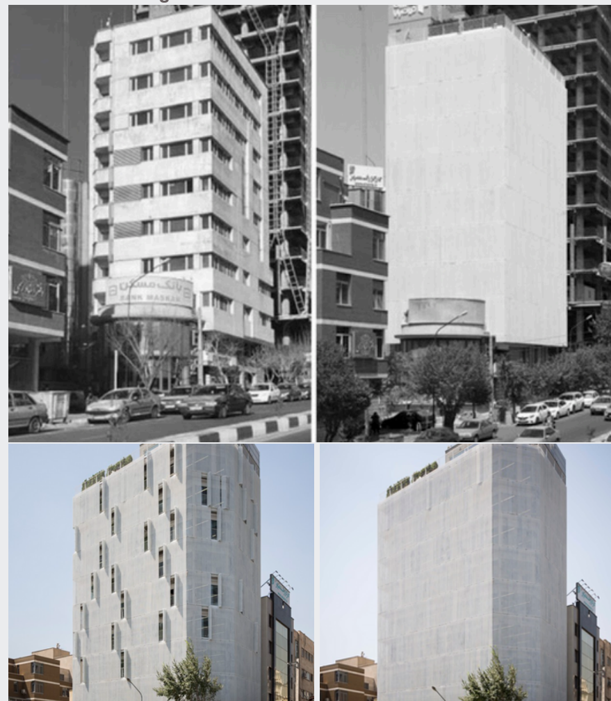
Figura 11 - Fachada edifício reabilitado
