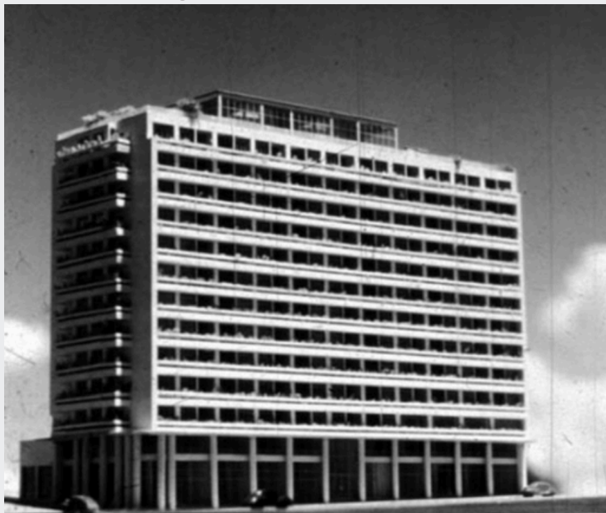
Figura 25 - Fachada Edifício Mara.
