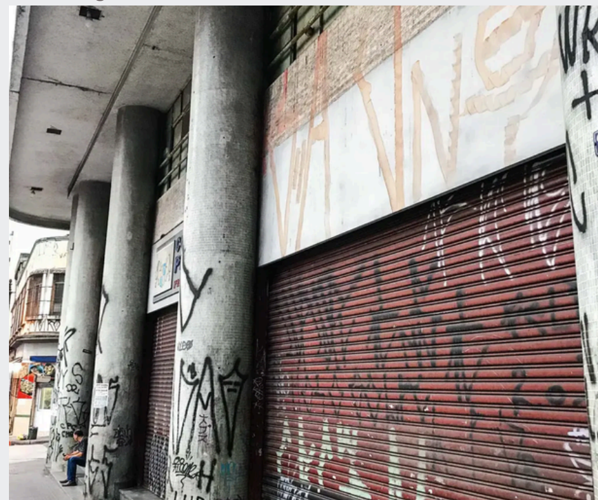
Figura 28 - Detalhes Pilotis Edifício Mara
