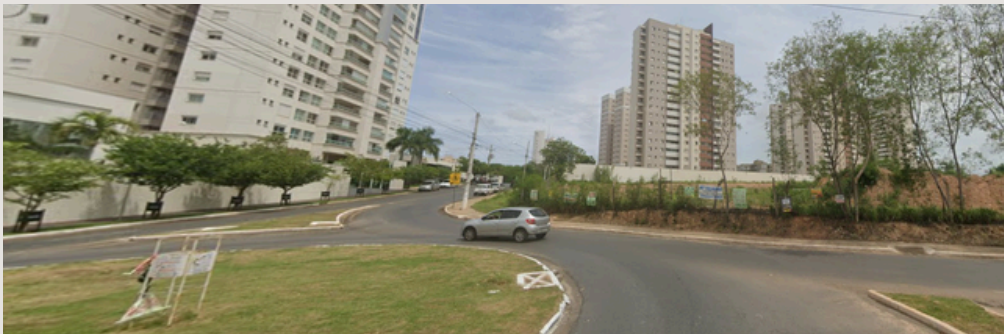
Figura 47 - Vista esquina do terreno
