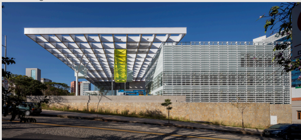
Figura 31 - Centro Cultural de Barro Preto - visão externa
