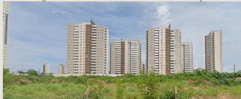
Figura 52 - Edifícios atrás do terreno de intervenção
