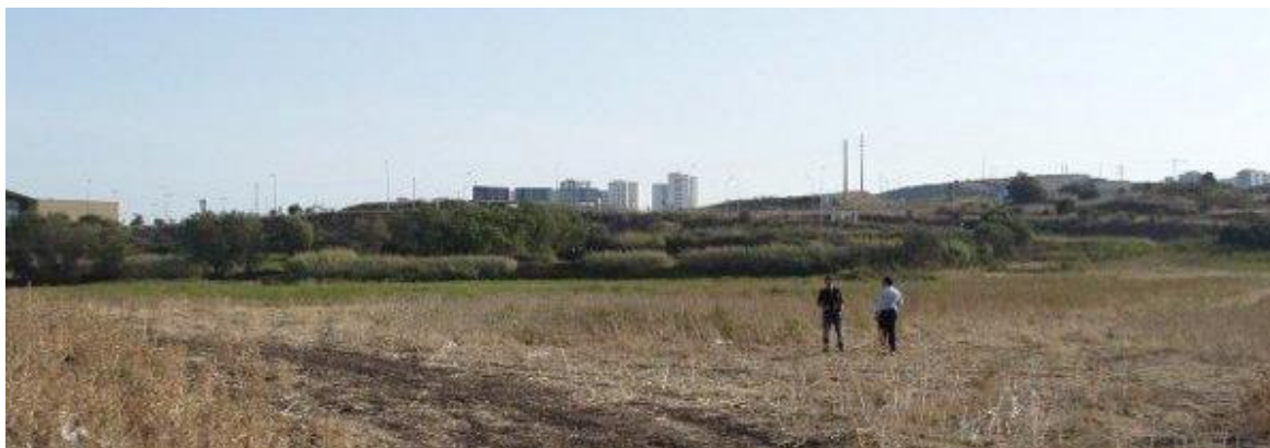
Imagem 03 – Foto do terreno no início da Construção. Fotografo: Fernando Guerra e Sérgio Guerra.
