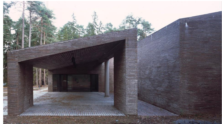
Figura 15 - Detalhe da fachada
