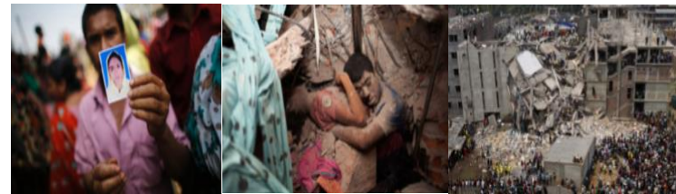
Figura 10 – Imagens do Desabamento do Edifício Rana Plaza, Dhaka, Bangladesh
