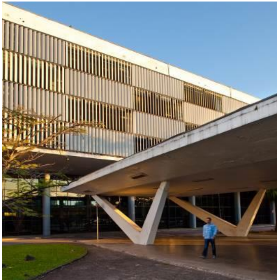
Figura 38 – Vista da Fachada – Pavilhão Cicillo
