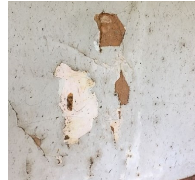
Figura 31: Reboco pulverulento
