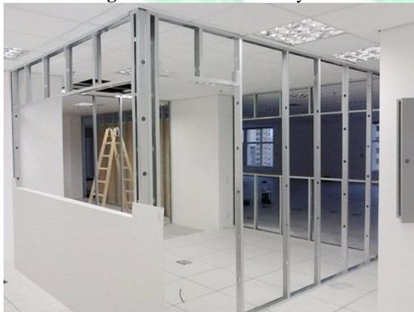
Figura 58: Estrutura de Drywall
