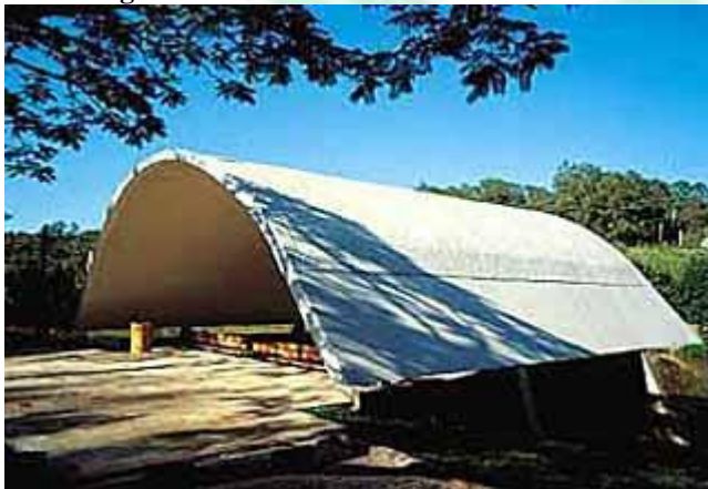
Figura 60: Cobertura em Casca de concreto.
