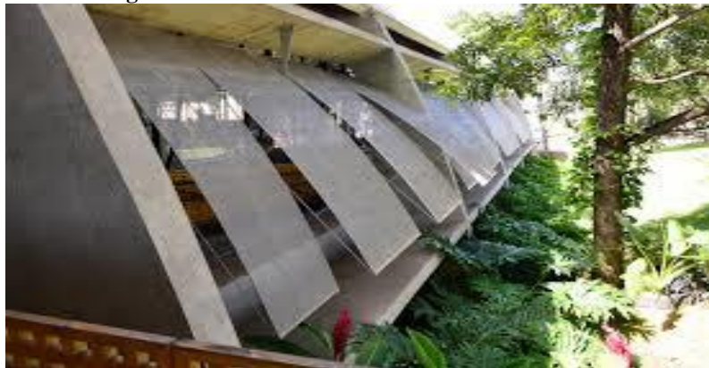
Figura 37: Brises Móveis controlam a luminosidade.
