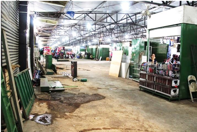
Figura 02: Circulação/Estrutura Interna antes da reforma.
