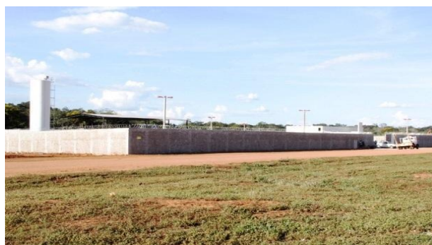
Figura 40 - Centro de detenção provisória de Lucas do Rio Verde Fonte: mtagora, 2015.
