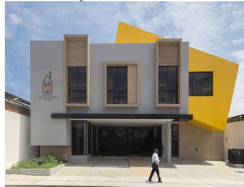
Figura 7: Fachada da casa Ronald
