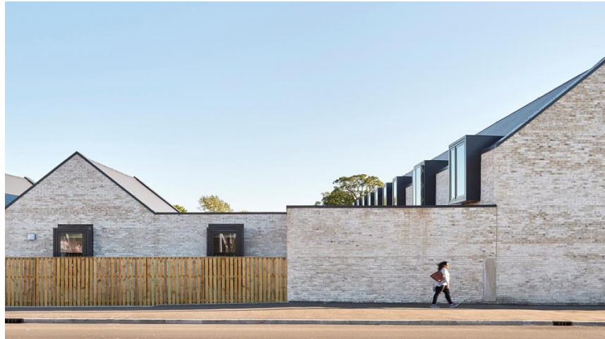
Foto 10: Entrada house Mcdonald
