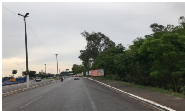
Figura 24 – Imagem testada e via principal do terreno
