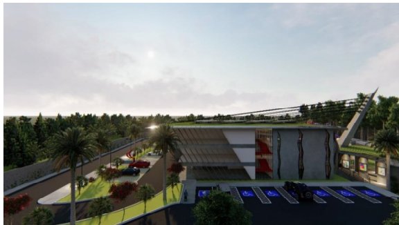
Figura 61: Maquete eletrônica vista lateral direita do bloco A Fonte: Acervo do Autor, 2018.
