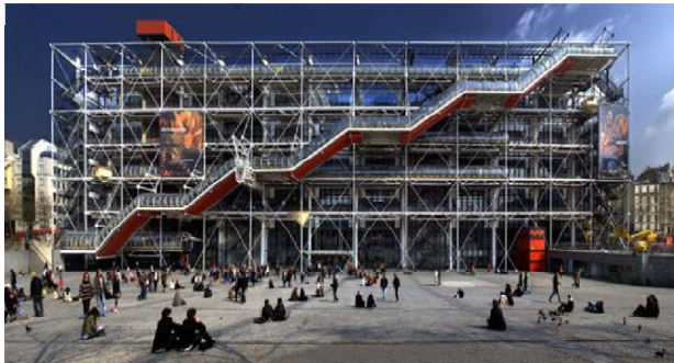
Figura 7: Centro Cultural Georges Pompidou - Paris Fonte: Disponível em: https://www.dicasparis.com.br/2015/06/centro-museu-georges-pompidou-em-paris-franca.html# . Acesso em 12 set 2018.
