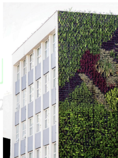
Figura 11: Edifício Mackenzie (parede verde)
