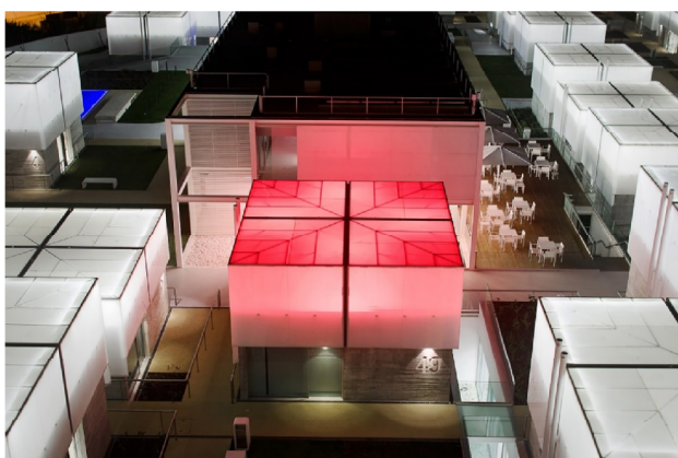
Figura 16: Sistema de Automação Residencial no Complexo Social em Alcabiche.
