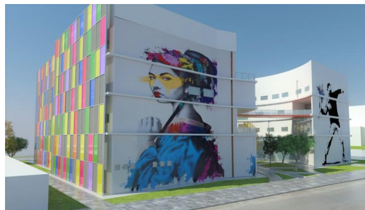
Imagem 54 – Fachada Posterior. Fonte: Arquivo Pessoal.
