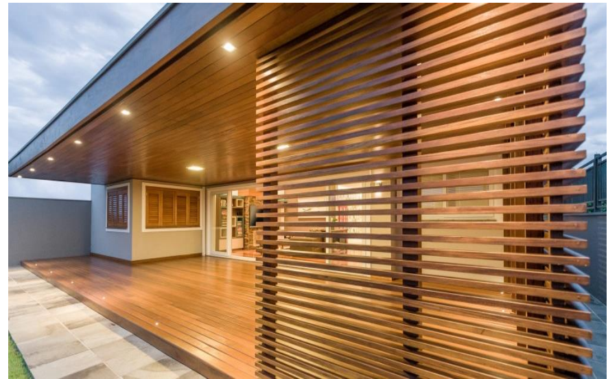
Figura 48: Brises de madeira.
