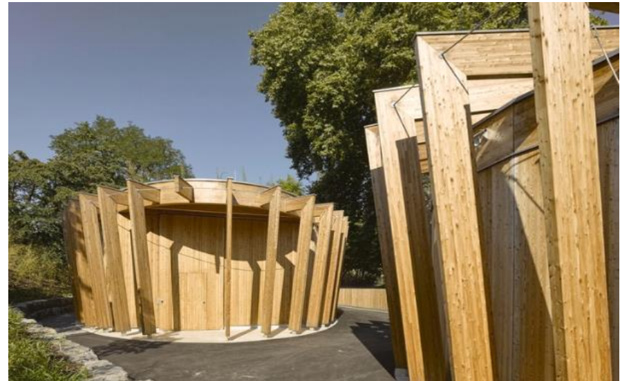
Figura 27: Fachada dos Recintos.
