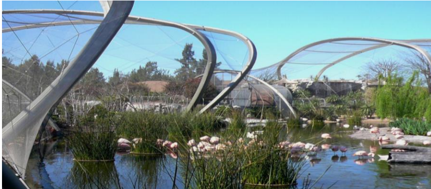
Figura 24: Estruturas em Aço.
