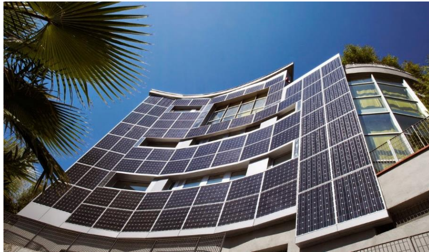
Imagem 4 – Placa solar como revestimento de fachada.
