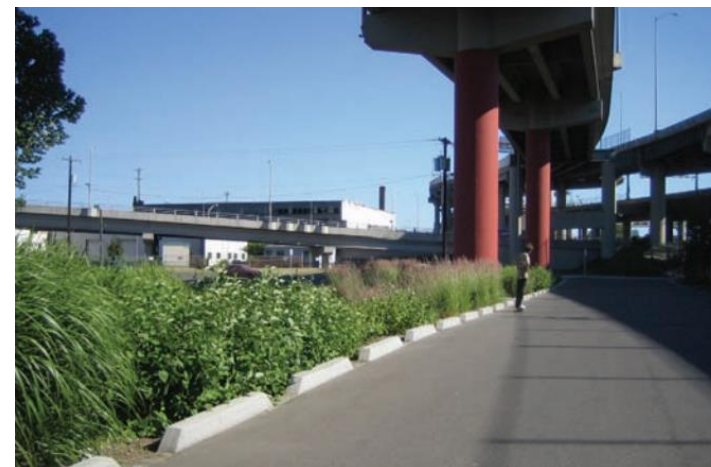
Figura 6: Biovaleta de um estacionamento
