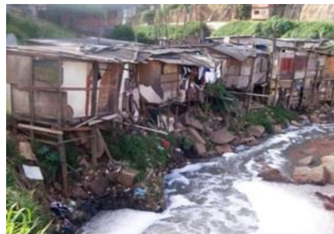
Figura 18: Área próxima ao córrego antes da intervenção
