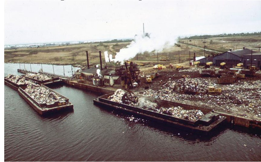
Figura 16. Aterro à margem do rio Arthur Kill
