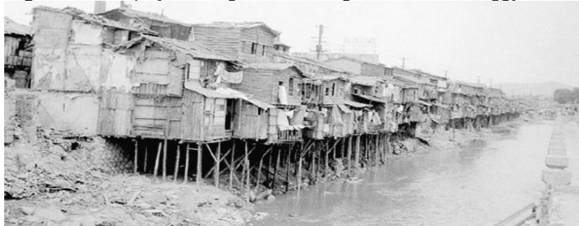
Figura 12. Ocupações irregulares a margem do rio Cheonggyecheon
