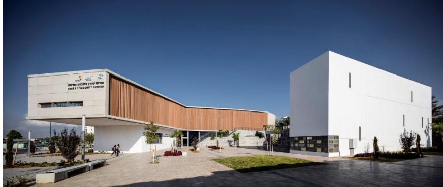
Figura 08 - Fachada Principal dos edifícios interligados.
