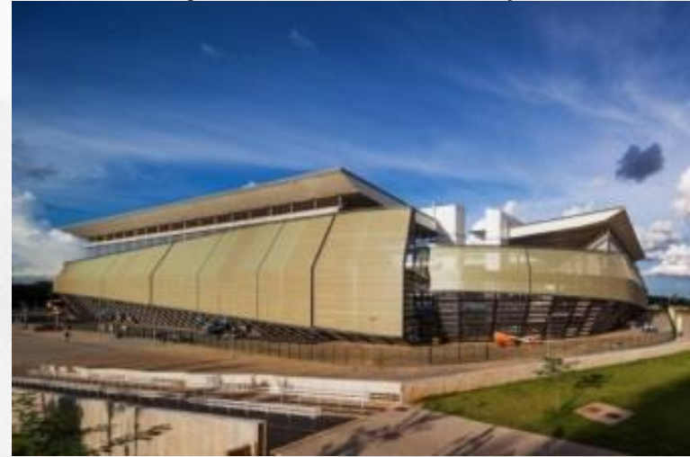
Figura 18 - Vista externa da edificação
