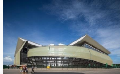
Figura 30 - Telas Soltis FT 381 – Arena Pantanal – Cuiabá-MT
