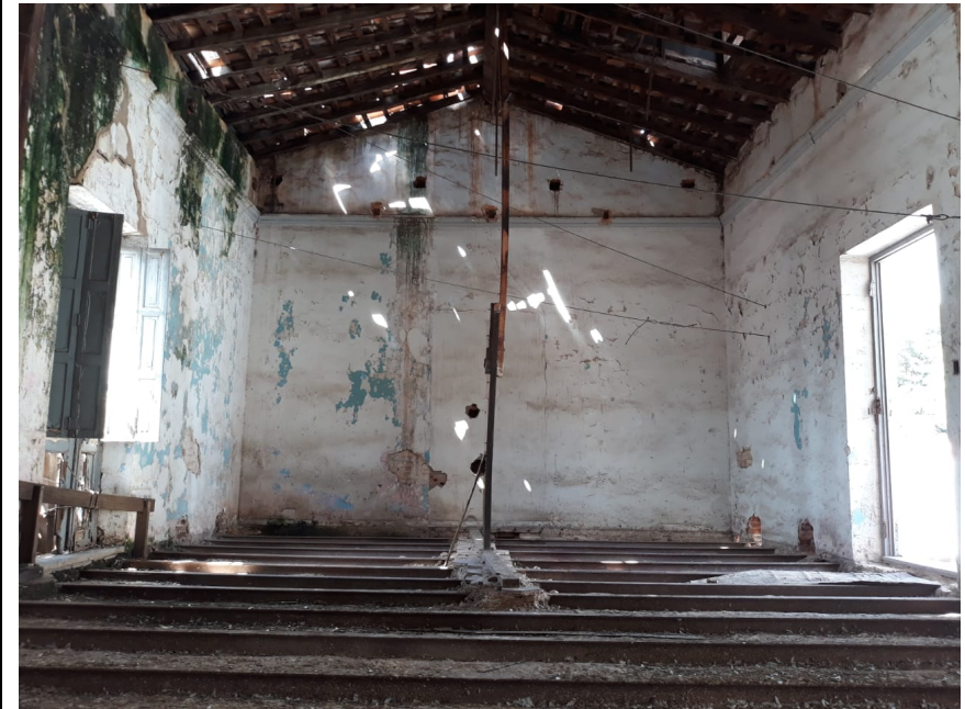
Figura 32 – 1º Pavimento da edificação 03
