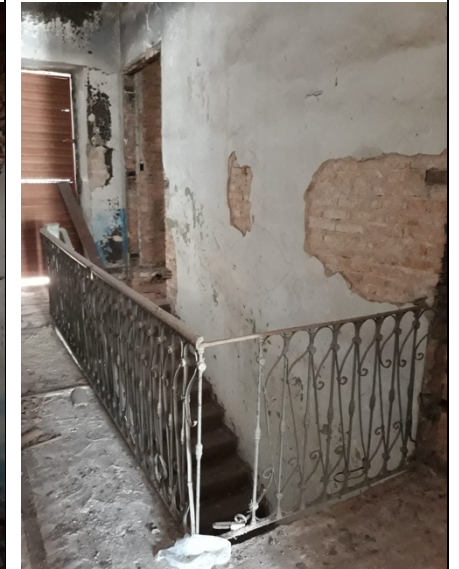
Figura 35 - Escada da edificação 02
