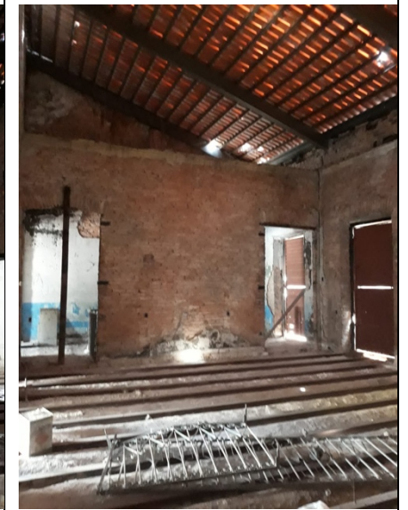
Figura 30 - 1º Pavimento da edificação 02
