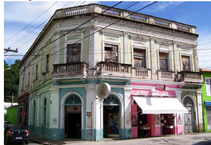
Figura 22 - Fachada do Edifício no início do Sec. XXI
