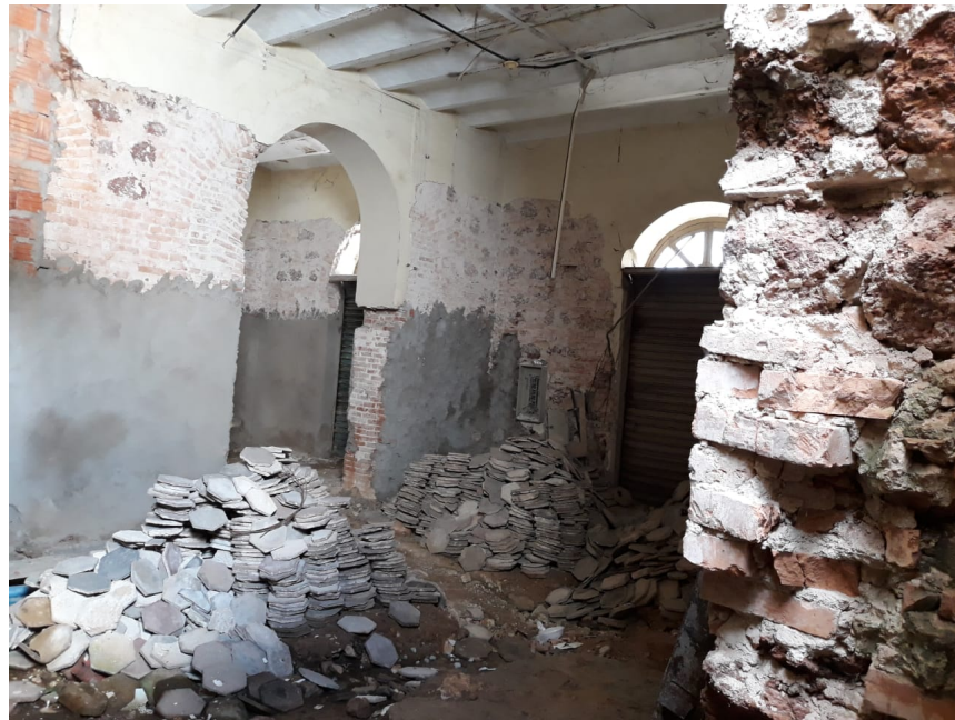
Figura 33 - Pavimento térreo da edificação
