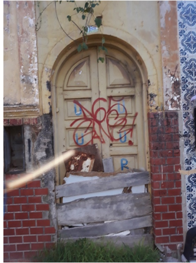
Figura 64 - Porta de acesso original
