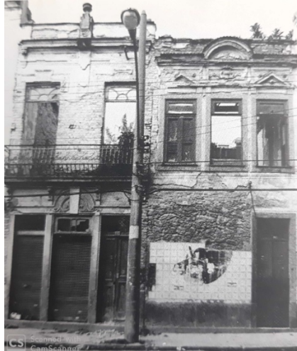
Figura 13 - Fachada dos Imóveis nº 145/147 em 1999
