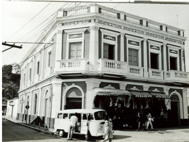
Figura 21 - Fachada do Edifício segunda metade do Sec. XX
