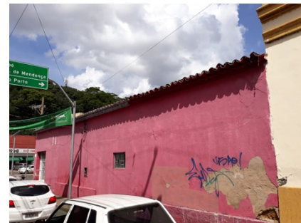
Figura 36 - Fachada Rua Campo Grande
