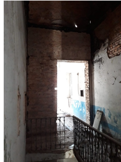
Figura 34 - Escada da edificação
