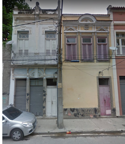
Figura 14 - Fachada dos Imóveis nº 145/147 em 2017
