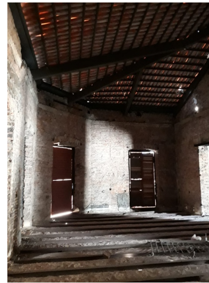
Figura 29 - 1º Pavimento da edificação 01
