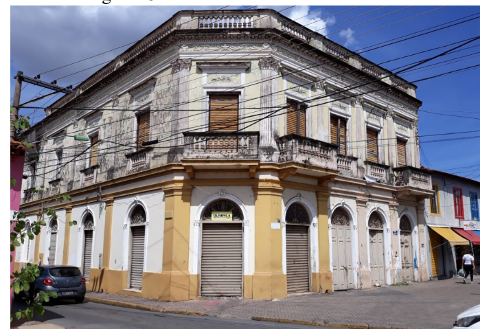
Figura 23 - Fachada do Edifício Atualmente
