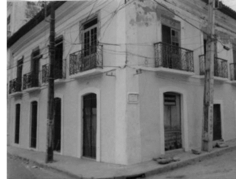
Figura 9 - Fachada do Imóvel nº 66 em 1986
