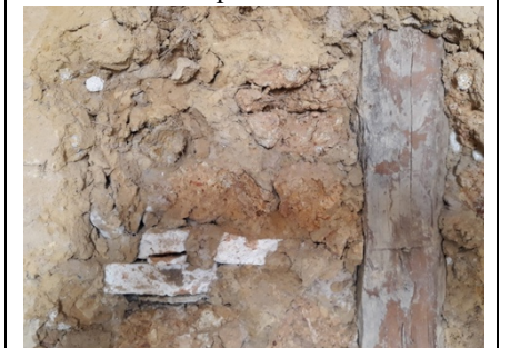
Figura 37 - Detalhe Fachada Rua Campo Grande
