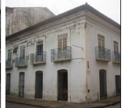
Figura 10 - Fachada do Imóvel nº 66 em 2010
