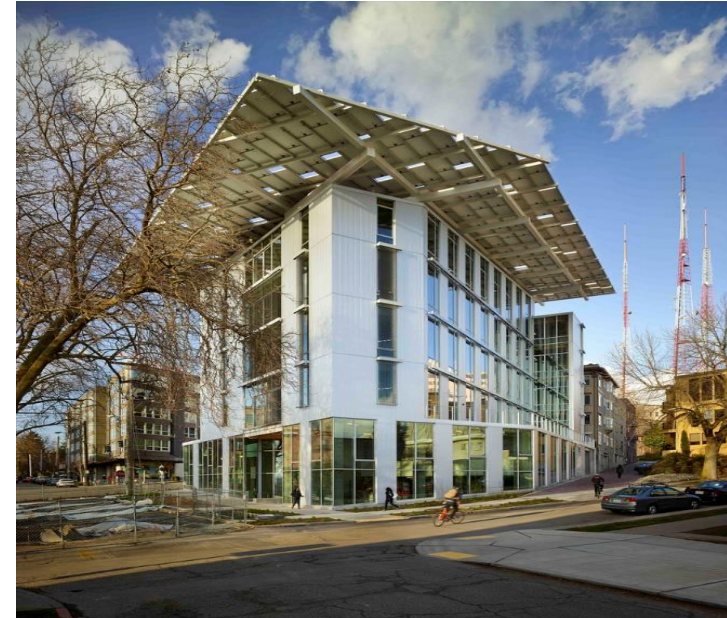
Figura 15 - Modulação da cobertura com painéis solares.
