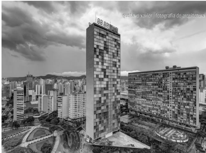
Figura 6 - Edifício JK, Belo Horizonte, Brasil (1952).
