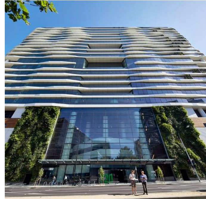
Figura 10 - Fachada principal da empresa Medibank, nota-se o uso de grandes aberturas e a presença de vegetação (jardim-vertical).
