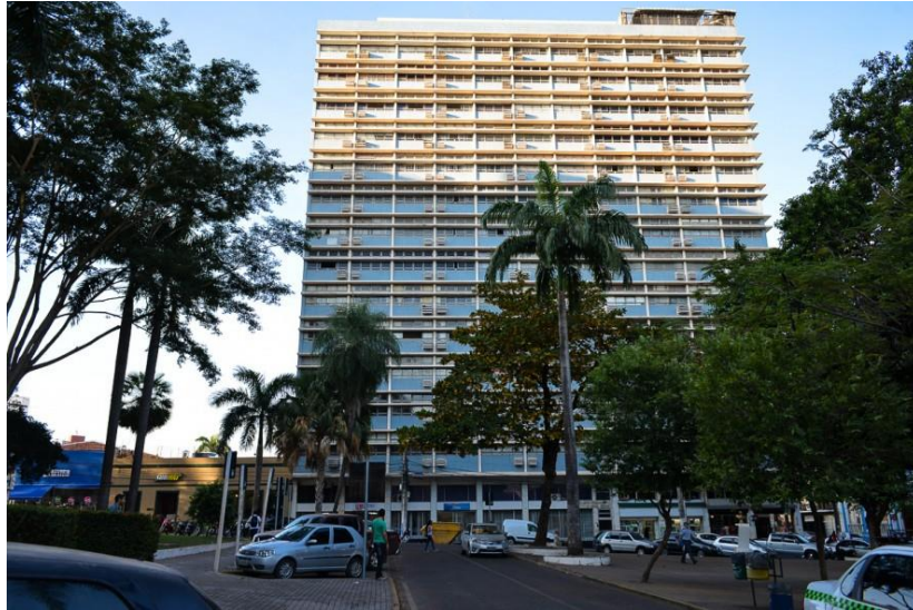
Figura 7 - Edifício Maria Joaquina primeiro edifício da capital mato-grossense (1969).
