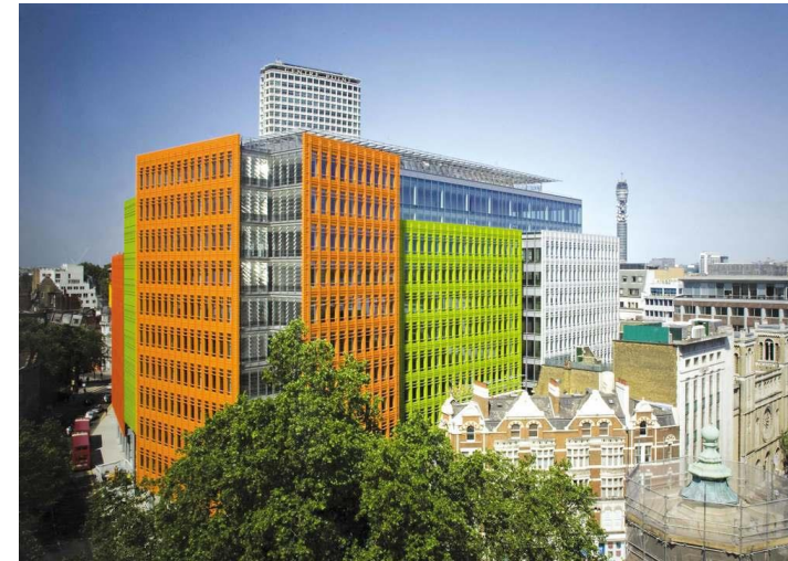
Figura 64 - Fachada Ventilada com armações coloridas.
