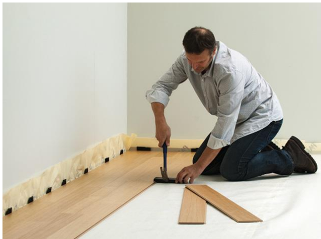
Figura 65 - Assentamento do Piso Flutuante.
