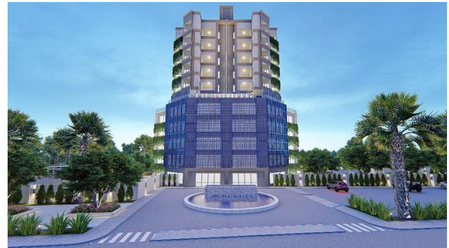
Figura 71 - Entrada e fachada principal com uso de painéis BIPV.
