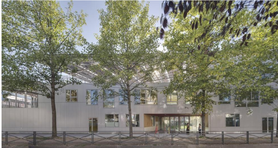
Figura 19 - Zero Energy school (Escola Energia Zero).
