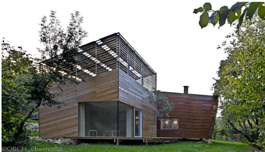
Figura 30 - Fachada lateral e posterior do TVZEB.
