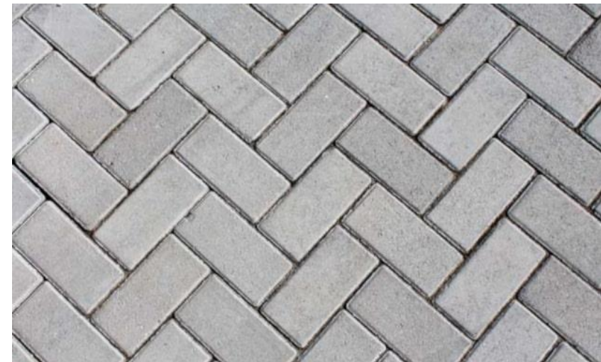
Figura 101: Piso intertravado retangular, a tipologia que será usada na proposta do projeto.
