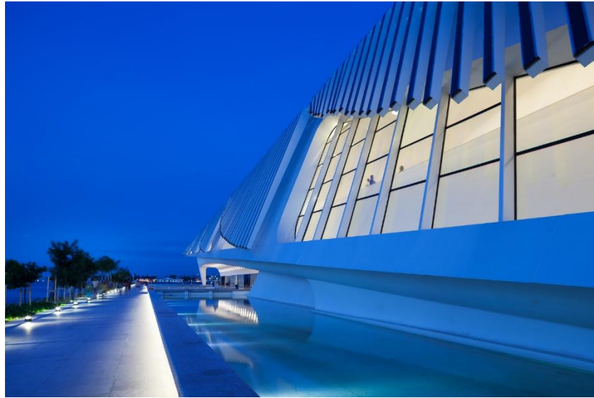
Figura 59: Passagem lateral da Edificação.
