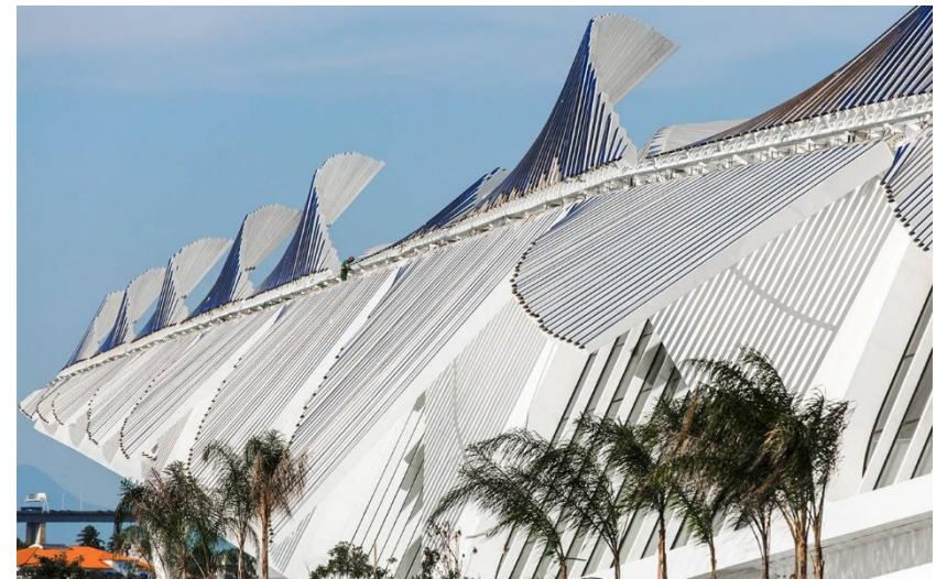
Figura 60: Painéis fotovoltaicos ajustáveis utilizados no Museu.
