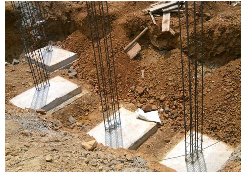
Figura 98: Sapata Isolada.
