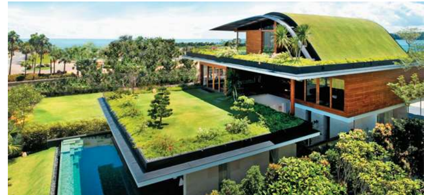
Figura 54 - Casa com telhado verde
