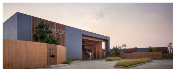
Figura 24- Fachada com diferentes cores, texturas e movimentos
