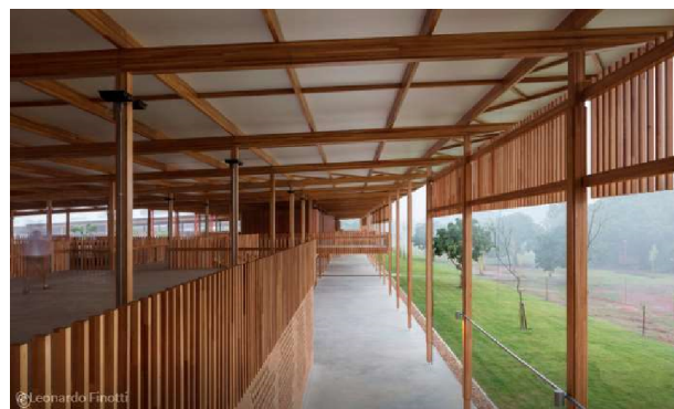
Figura 14: Brises Verticais em madeira
