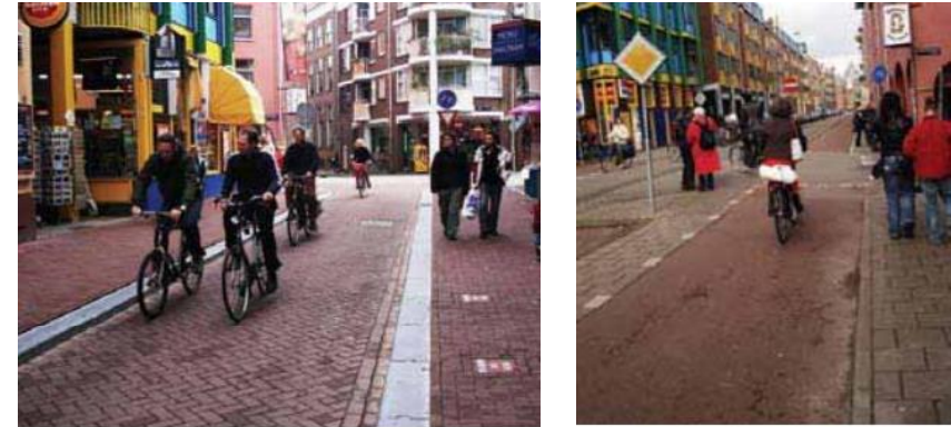
Figura 23: Exemplos de ciclovias em áreas adensadas, com coloração diferenciada e rebaixo do pavimento, Amsterdam – Holanda, 2006.
