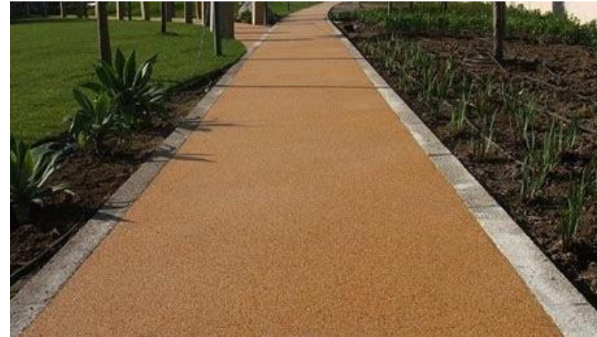
Figura 58: Ciclovia com piso drenante.
