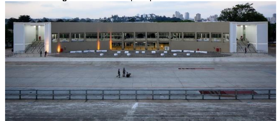
Figura 56 - Fachada principal do sambódromo
