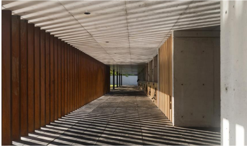
Figura 42: Madeira como elemento de vedação vazado
