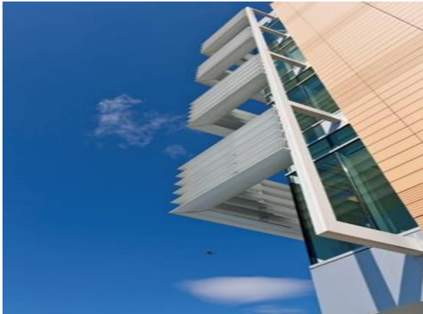
Figura 34: Painéis de metal e vidro
