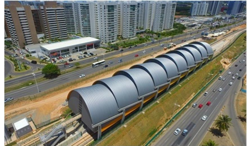
Figura 59: Cobertura do metrô de Salvador
