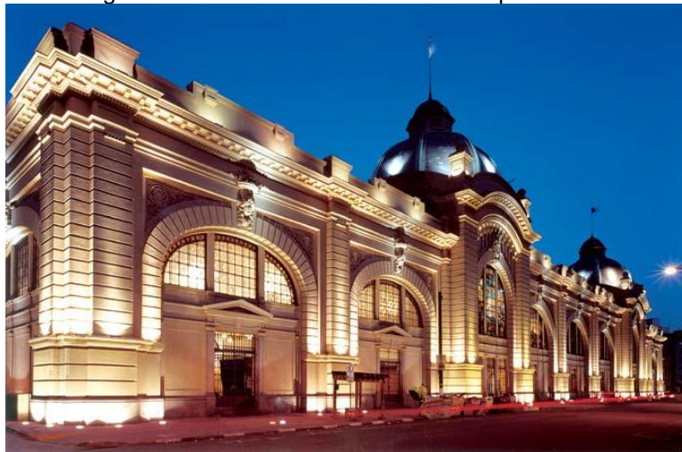
Figura 32: Fachada do Mercado Municipal de SP
