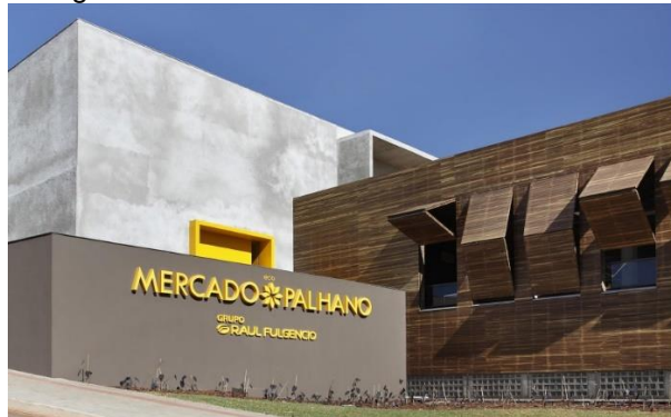
Figura 37: Fachada do Ecomercado Palhano
