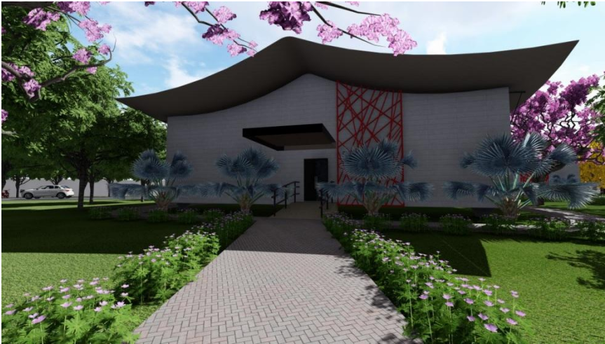
Figura 49. Fachada Setor Oficinas
