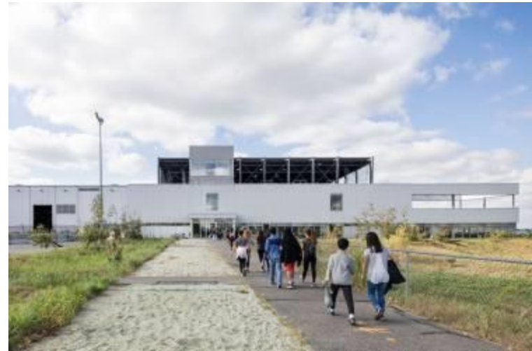
Figura 15 - Entrada para o bloco Administrativo/Educacional
