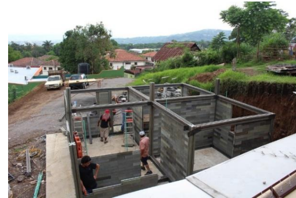
Figura 53 - Montagem da construção
