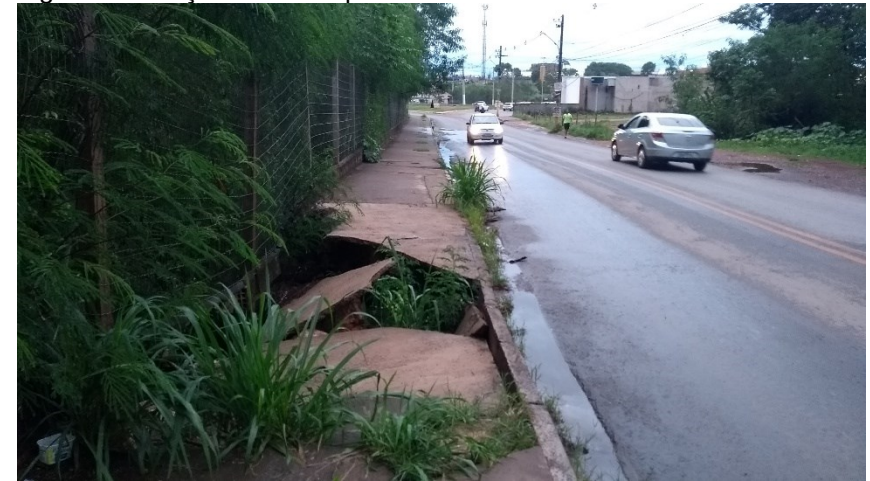
Figura 44: Calçada do lado posterior da via.
