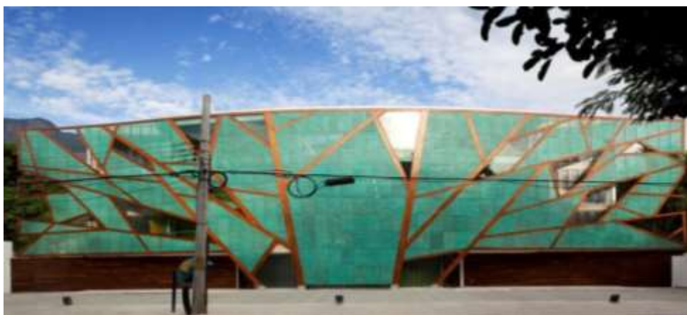
Figura 34: Fachada – Escola Mopi. Fonte: Arch Daily, 2017.
