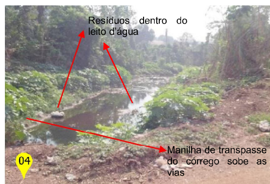
Figura 55 - Nível das vias mais próximos do leito do córrego
