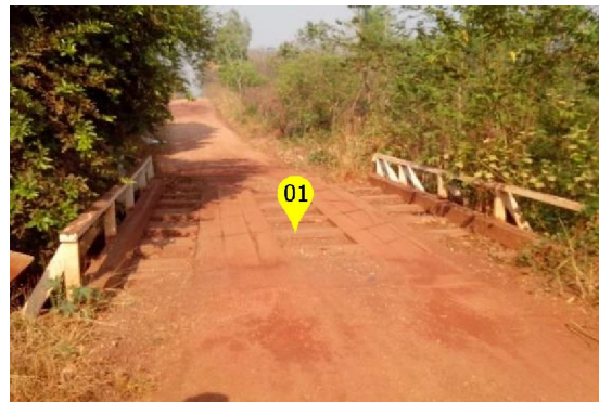
Figura 47 - Ponte sobre o córrego Traíras,
