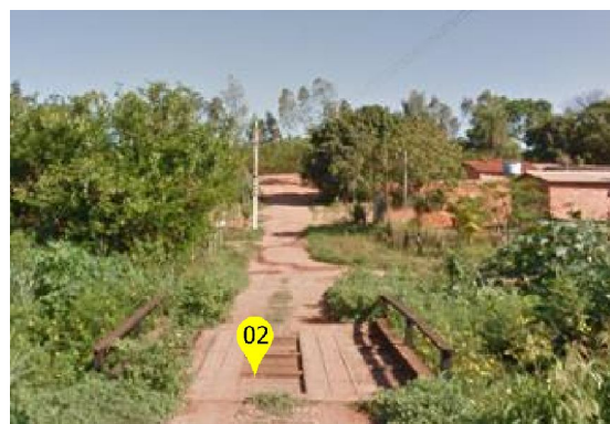
Figura 51 - Via de acesso rua d1, ponto 02 ,
