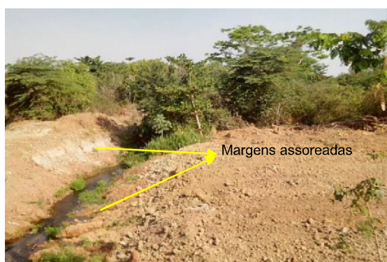
Figura 74 - Leito do córrego e margens assoreadas
