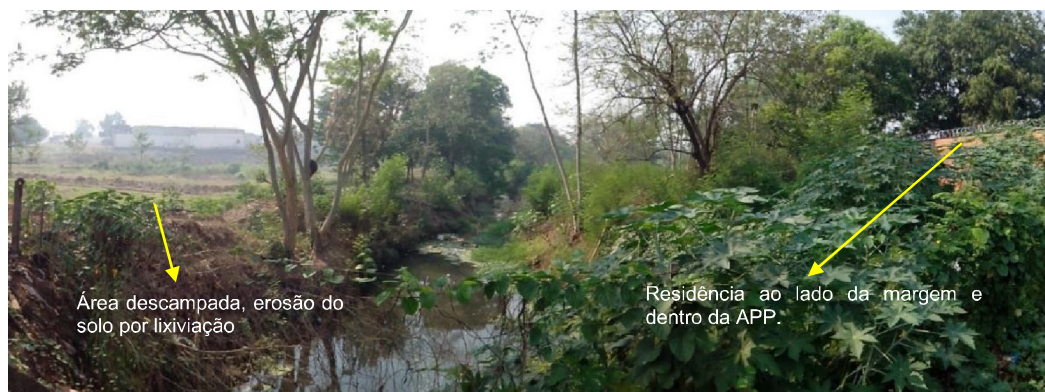
Figura 70 - Foto panorâmica a jusante do córrego sobre a ponte no ponto 09
