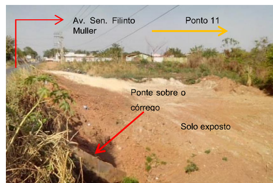
Figura 73 - Área modificada por obras no Ponto 10
