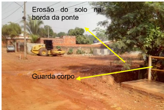
Figura 102 - Ponto 17 sobre a ponte do córrego traíras, rua Y
