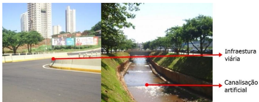
Figura 20 - Córrego Prosa canalizado, Campo Grande-MS
