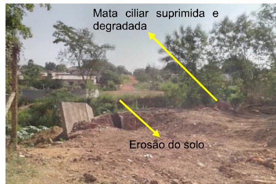
Figura 95 - Ponto 15, erosão, solo exposto e pedaços quebrados restantes de construções no ponto 15
