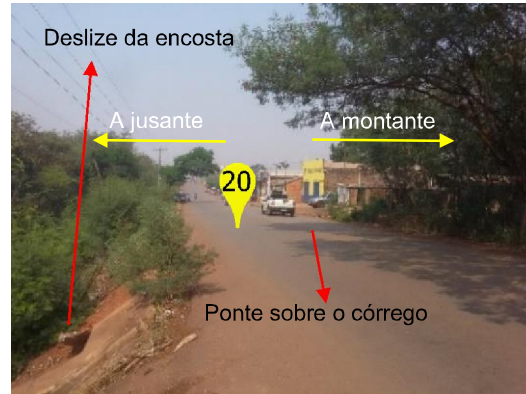
Figura 114 - Ponto final 20 , ponte sem sinalização e segurança
