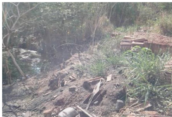
Figura 79 - Margem degradada do córrego no lado da rua prof. Adalgisa de Barros
