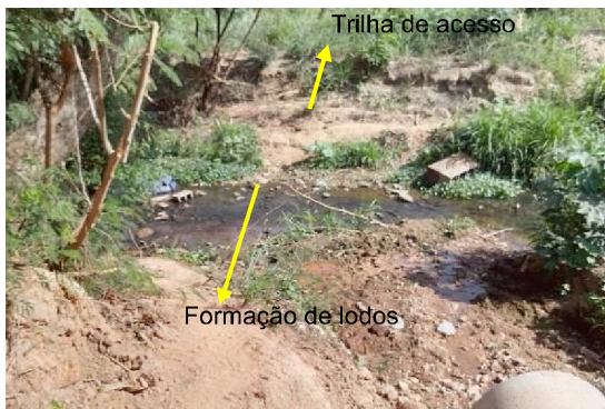
Figura 94 - Ponto 15, leito do córrego usado como circulação de pessoas entre os lados da via no ponto 15
