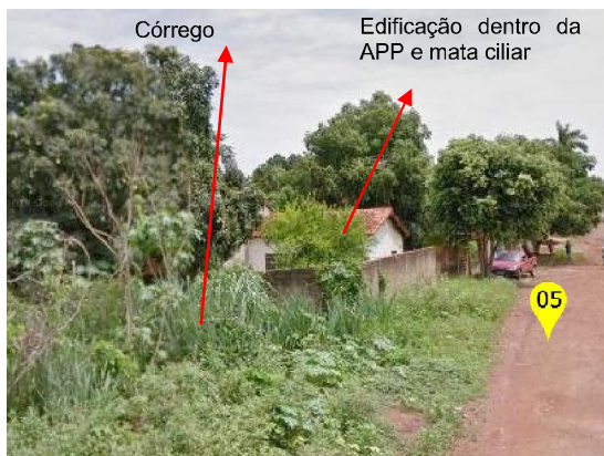
Figura 56 - Rua K, trecho sem pavimentação asfáltica no ponto 05
