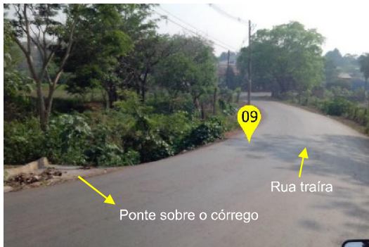
Figura 68 - Rua traíra ponto 09 , ponte sobre o córrego
