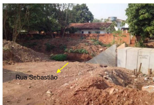
Figura 61 - Edificações dentro da app ao lado das margens e em situação de risco no ponto 06
