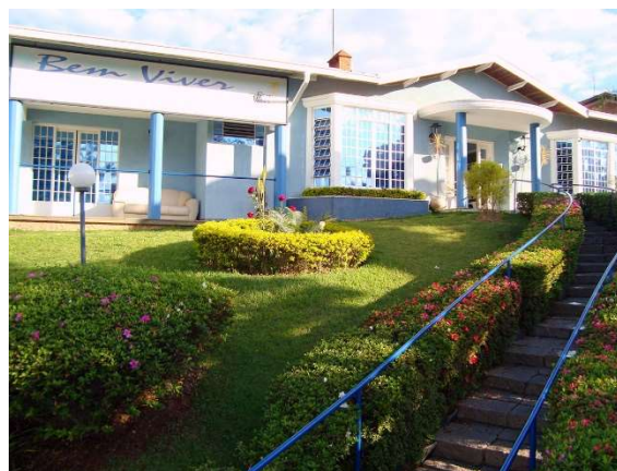
Figura 12: Fachada principal da Unidade 1
