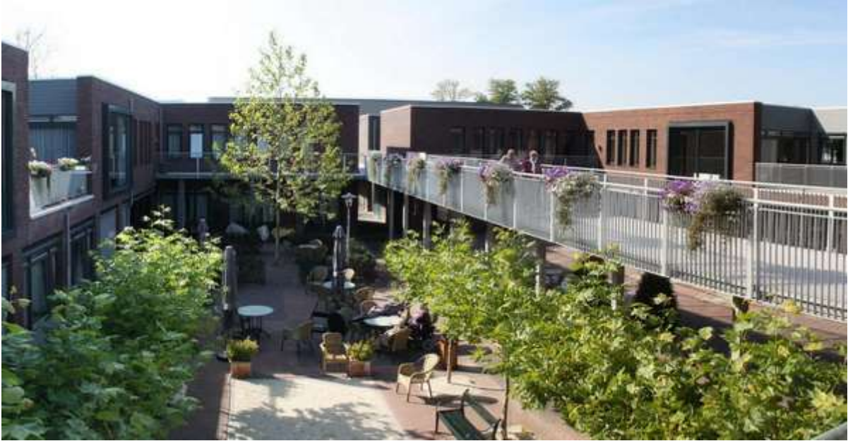
Figura 27: Vista da passarela
