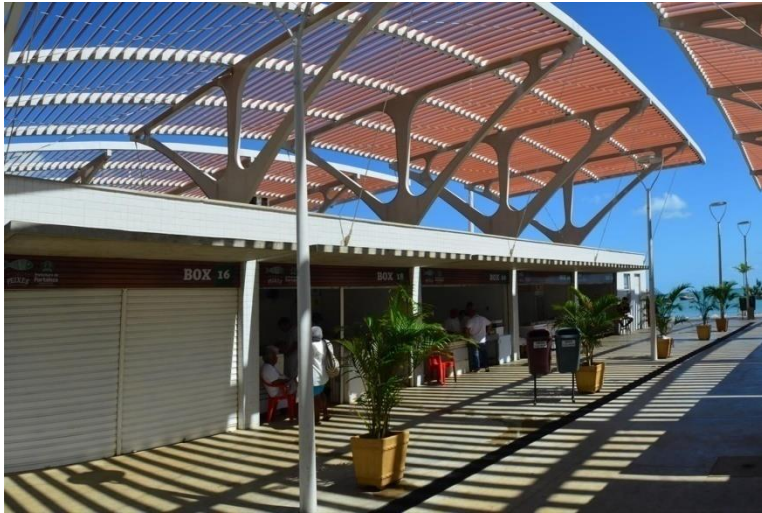
Figura 17: Detalhe da cobertura curva.
