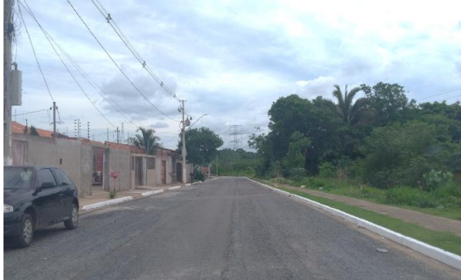
Figura 41 - Vista da Rua K
