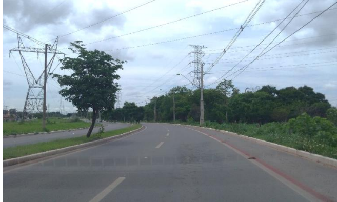
Figura 37 - Vista da Avenida das Torres
